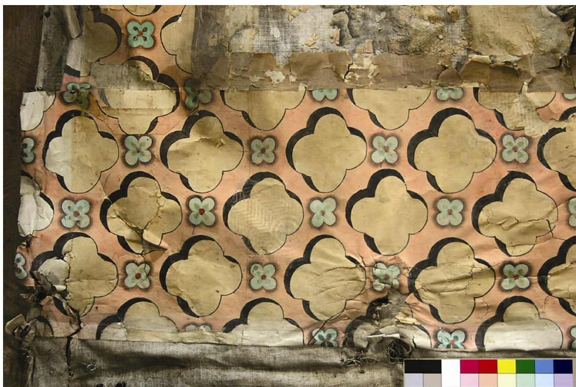
Obr. 40 Poškození bordury v levém dolním rohu – trhliny, zvlnění, sklady a otisky bot
