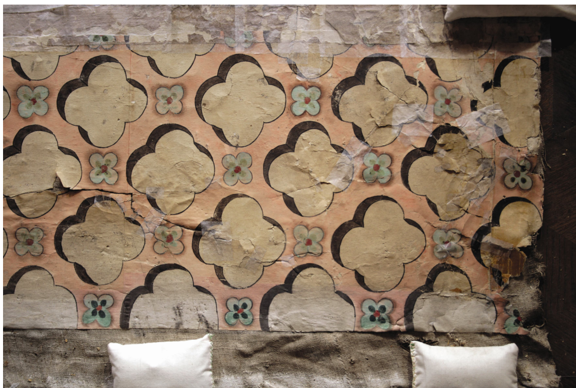
Obr. 53 Část bordury v pravém dolním rohu, stav po vyrovnání, mechanickém očištění a zajištění fragmentů kousky japonského papíru
