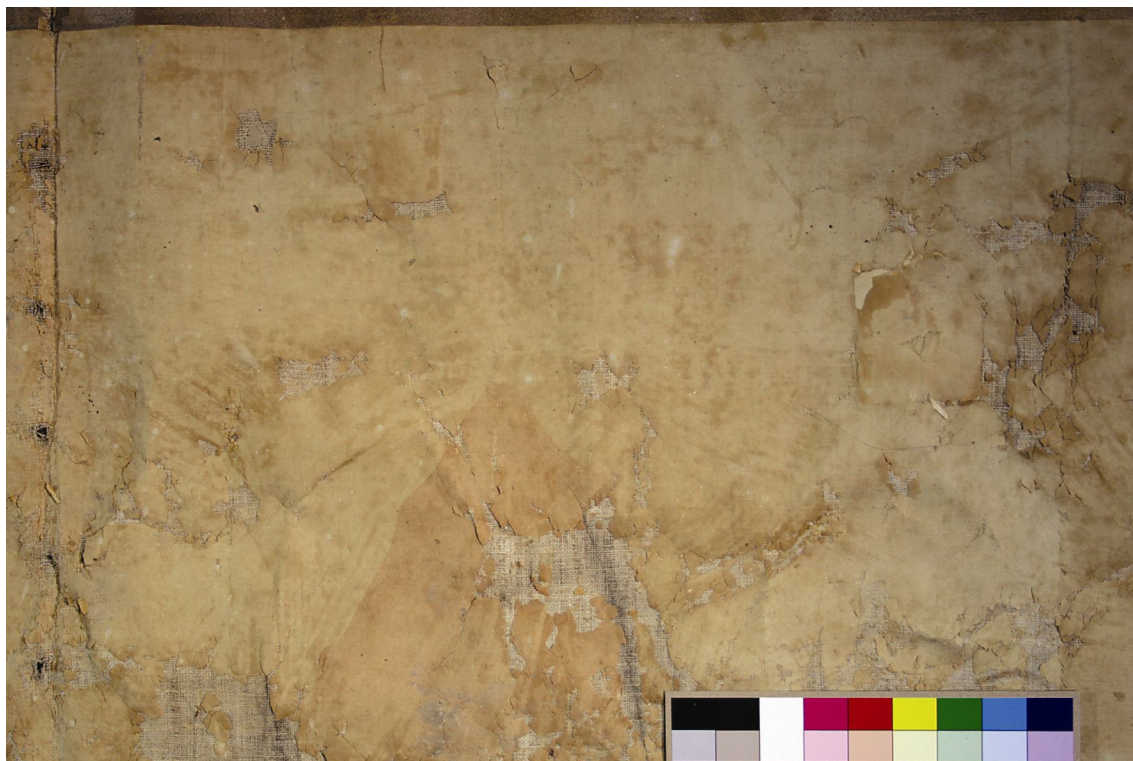
Obr. 25 Detail přiděleného úseku
