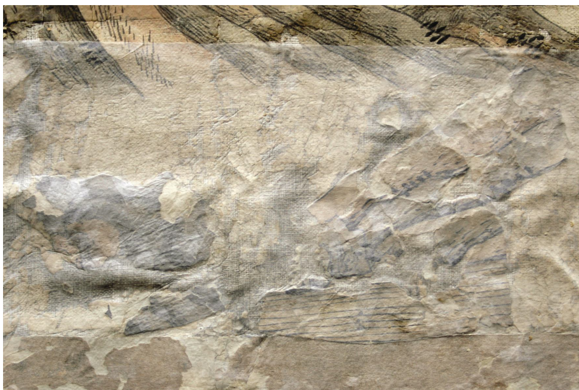
Obr. 51 Detail spodního okraje tapety, stav po přelepení japonským papírem
