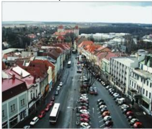
Obrázek 8 - Stav před revitalizací
