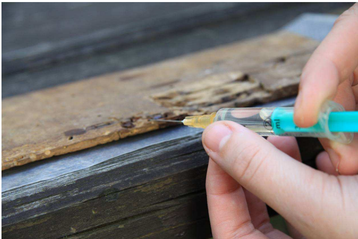
obr. č. 48 Petrifikace dřevěných desek
