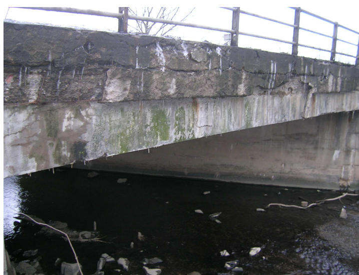
Obr.6 Znamky koroze betonu na mostě v Týništičku
