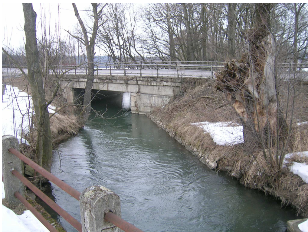
Obr.26 Most 083 Týništko – stav před demolicí
