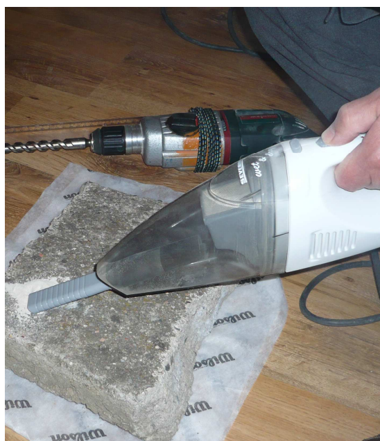
Obr.47 Odsávání vyvrtaného prachu pomocí ručního vysavače
