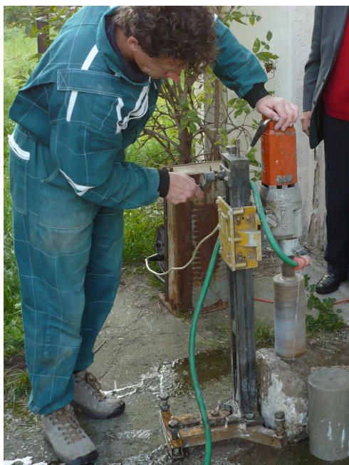
Obr.32 Provádění jádrového vývrtu z odebraného dílu demolovaného mostu
