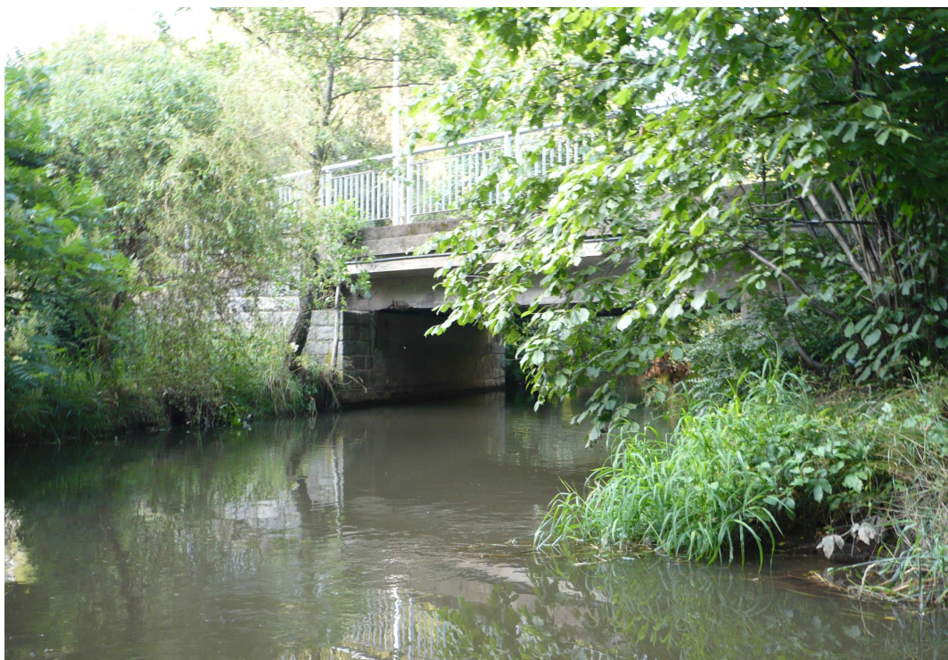
Obr.50 Most 34039-2 Mnětice – pohled proti proudu
