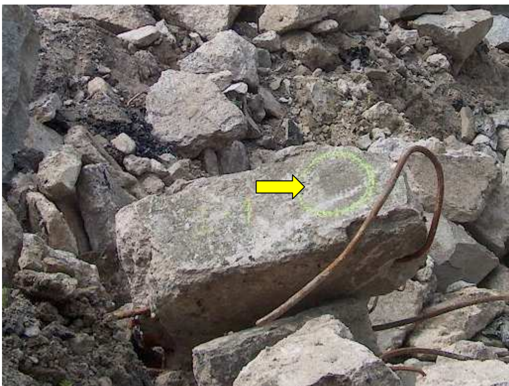
Obr.31 Část římsy s označením místa vývrtu
