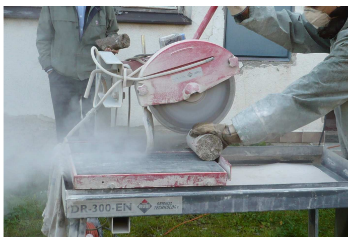
Obr.33 Řezání vrstev na diamantové pile
