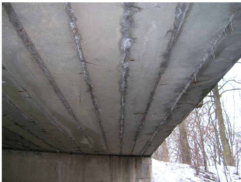
Obr.28 Pohled zespoda na nosnou konstrukci
