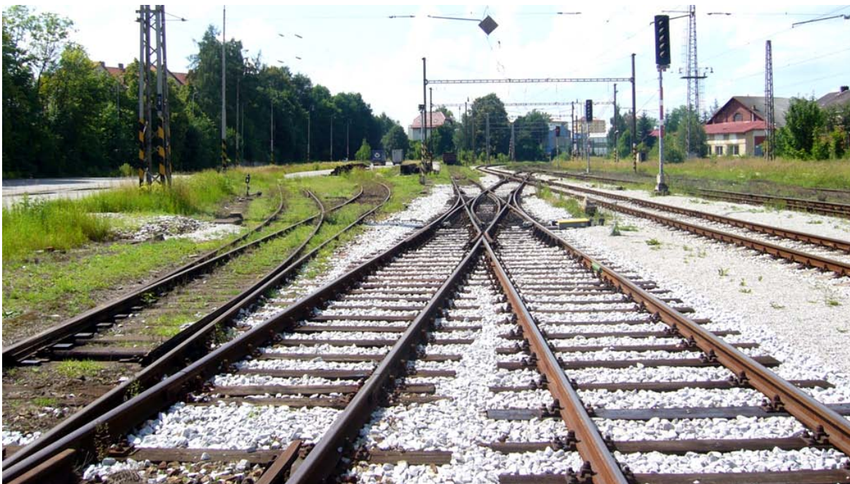
Obrázek Příloha A - 2 Pohled na střední zhlaví od St.1 k žst. Rantířov. Vlevo VNVK, místo nich plánovaná pozemní komunikace s trojbusovou tratí.
