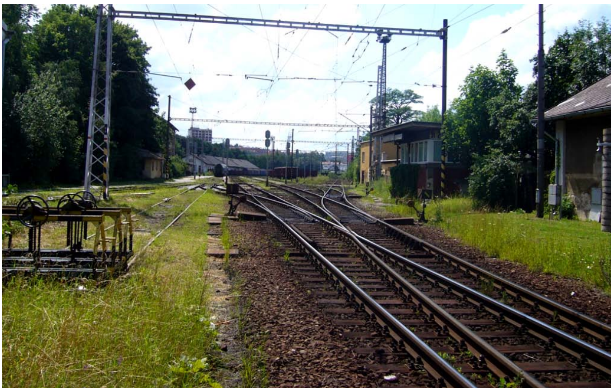
Obrázek Příloha A - 1 Pohled do stanice od žst. Jihlava.
