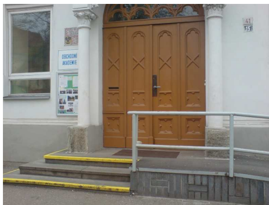
Obr. 26: Vchodové dveře OA Zdroj: Autor
