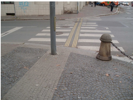
Obr. 28: Přejechod pro chodce Úřad práce Zdroj: Autor
