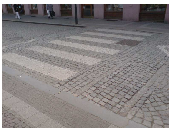
Obr. 47: Přejechod přes ul. Pražská Zdroj: Autor
