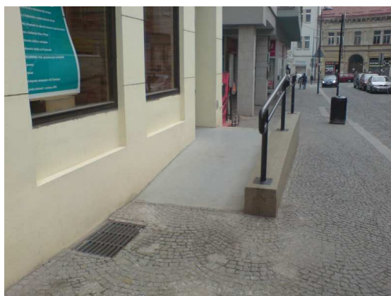
Obr. 36: Knihovna - bezbariérová rampa Zdroj: Autor
