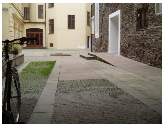
Obr. 40: Bezbariérová rampa dvůr Zdroj: Autor
