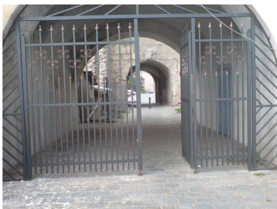
Obr. 41: Mříž před vstupem do MÚ Zdroj: Autor
