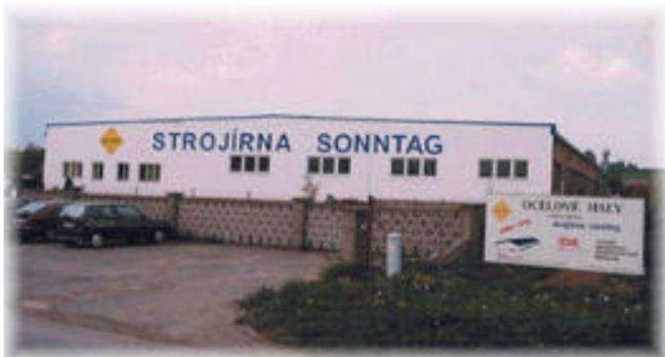
Obrázek 1: Vnější pohled na budovu Strojírny Sonntag s.r.o.
