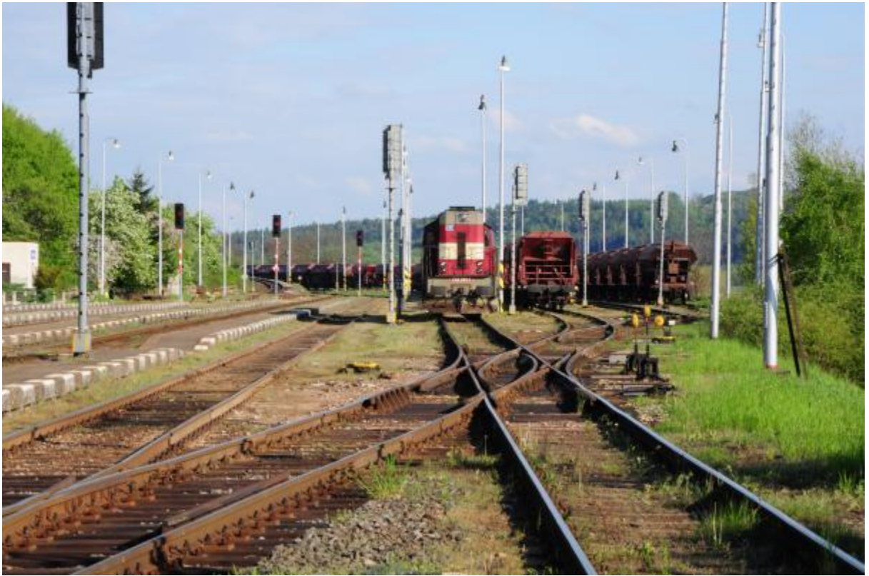
Obr.17 - Vlečková část stanice Libuň, křižovatková výhybka 102ab
