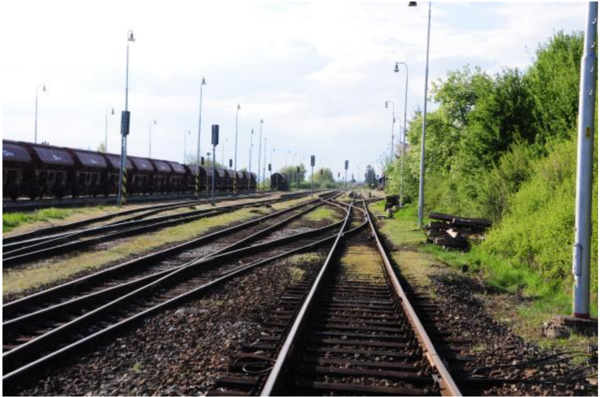
Obr.15 – Kolejové spojky 3-5 a 6-8
