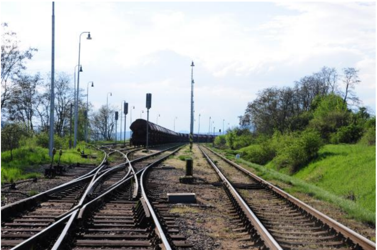
Obr.12 – Vlečková část stanice Libuň, křižovatková výhybka 101ab
