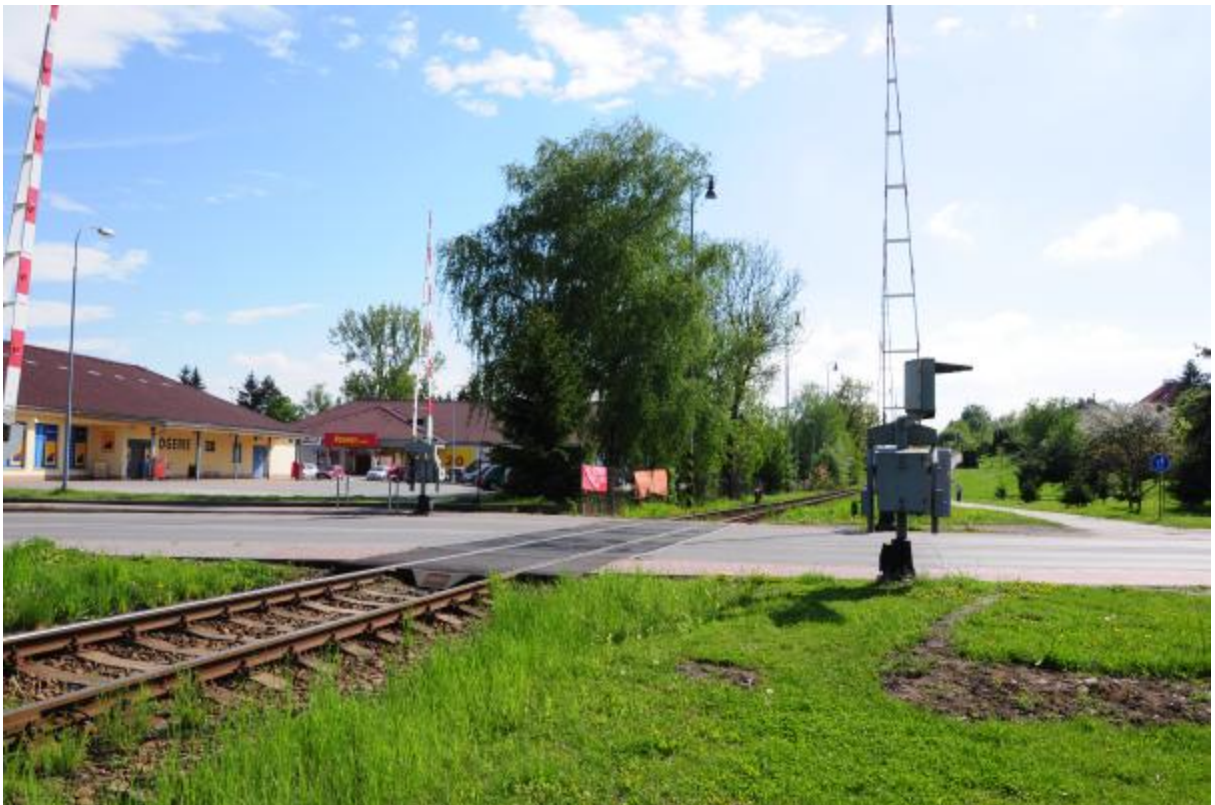
Obr.2 – Železniční přejezd v kilometru 0,484 (Jičín, silnice II/286)
