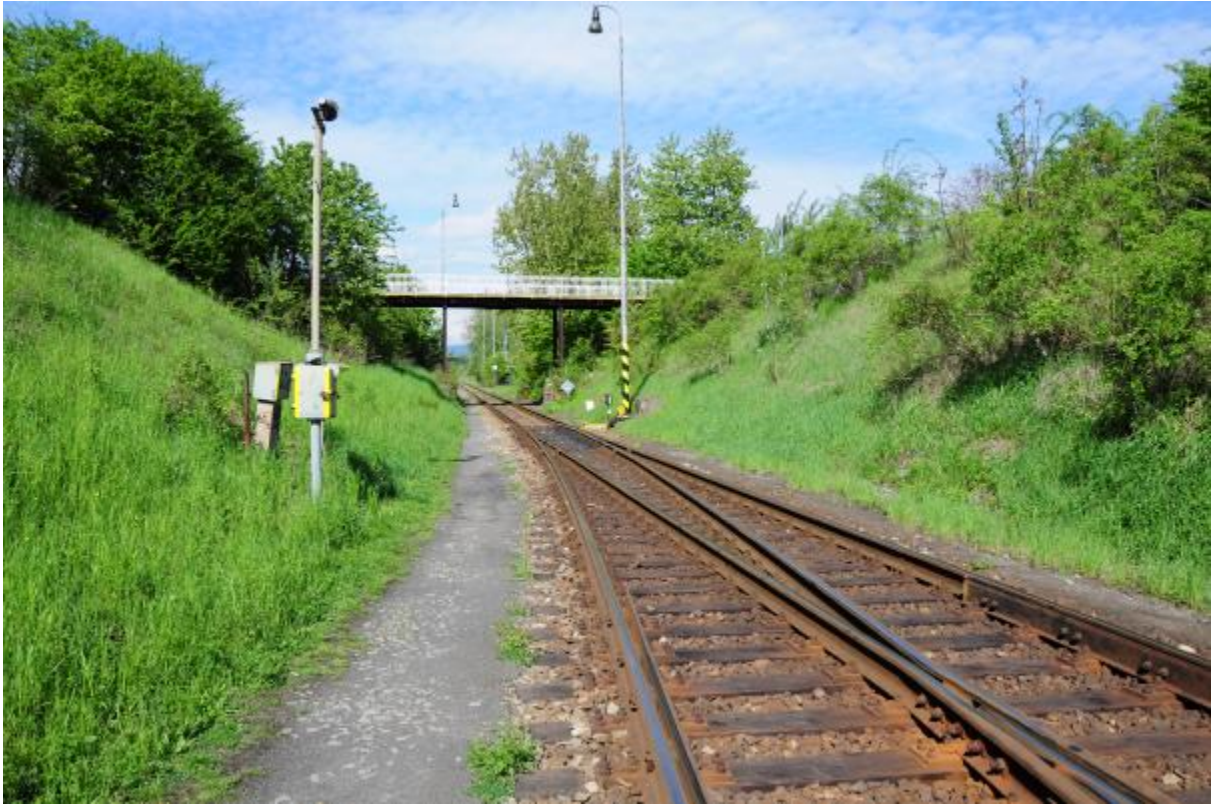
Obr.1 – Výhybka č.33 na severním zhlaví železniční stanice Jičín
