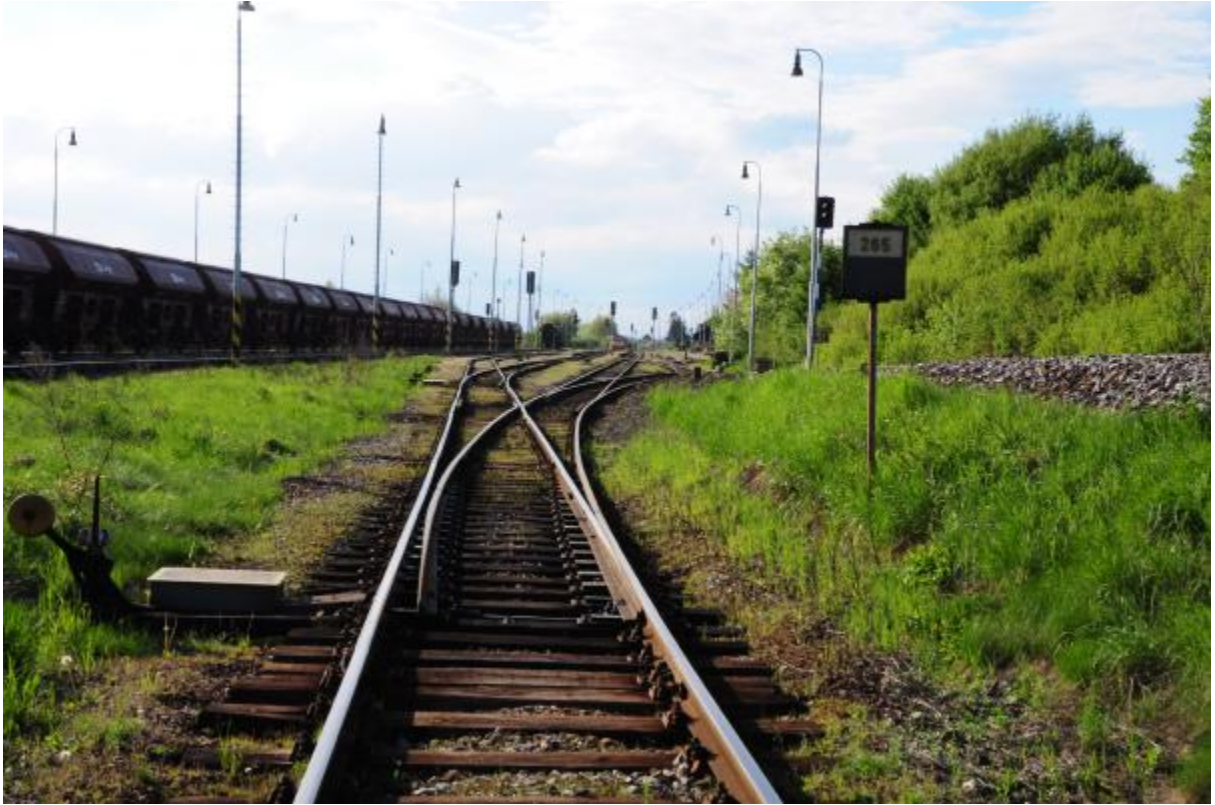
Obr.13 – Výhybka č.2, větvení dopravních kolejí
