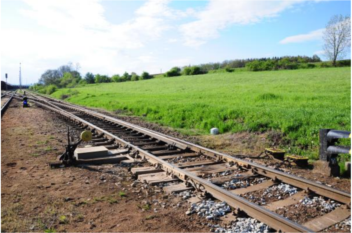
Obr.11 - Výhybka č.1 na jičtínském zhlaví železniční stanice Libuň
