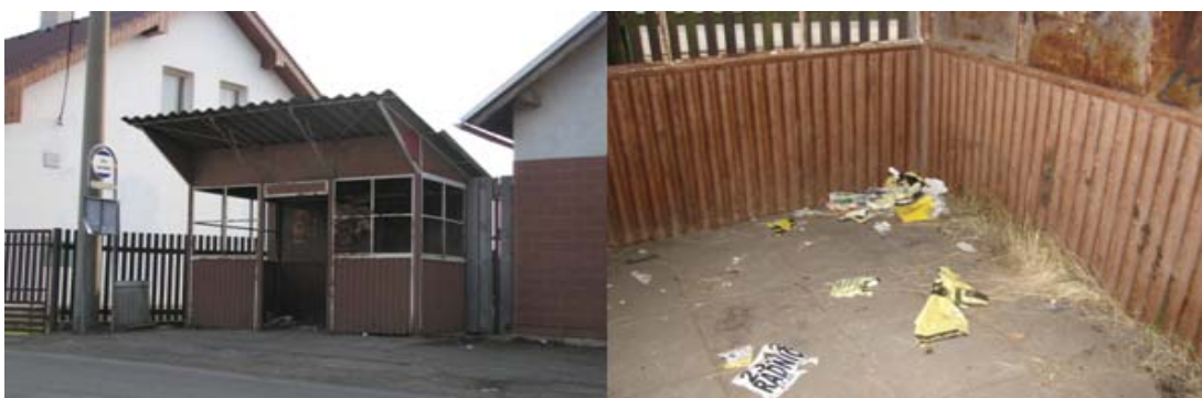
Obrázek 12 – Stav autobusové zastávky Břasy,, Stupno, žel. st.
