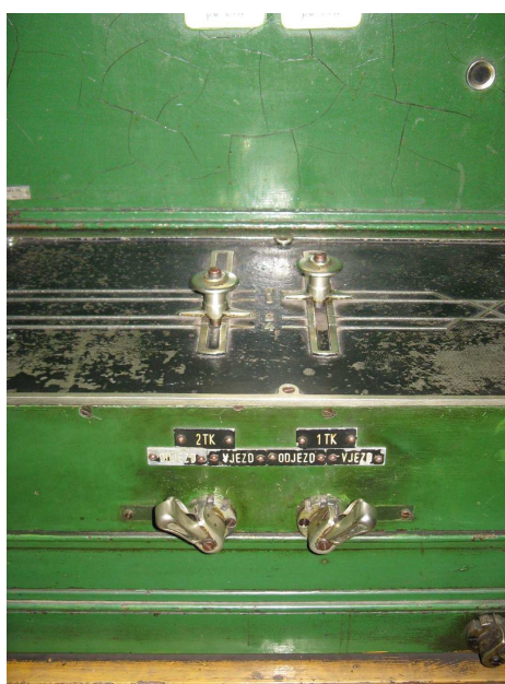
Obr. 2 – Posuvné knoflíky a směrové závěrníky
