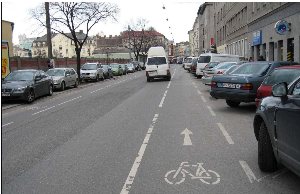
Obrázek 3 - Víceúčelový jízdní pruh pro cyklisty v mezikřižovatkovém úseku, zdroj [24]
