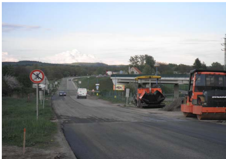
Obrázek 25: Rekonstrukce šetřeného úseku ve směru z centra České Skalice
