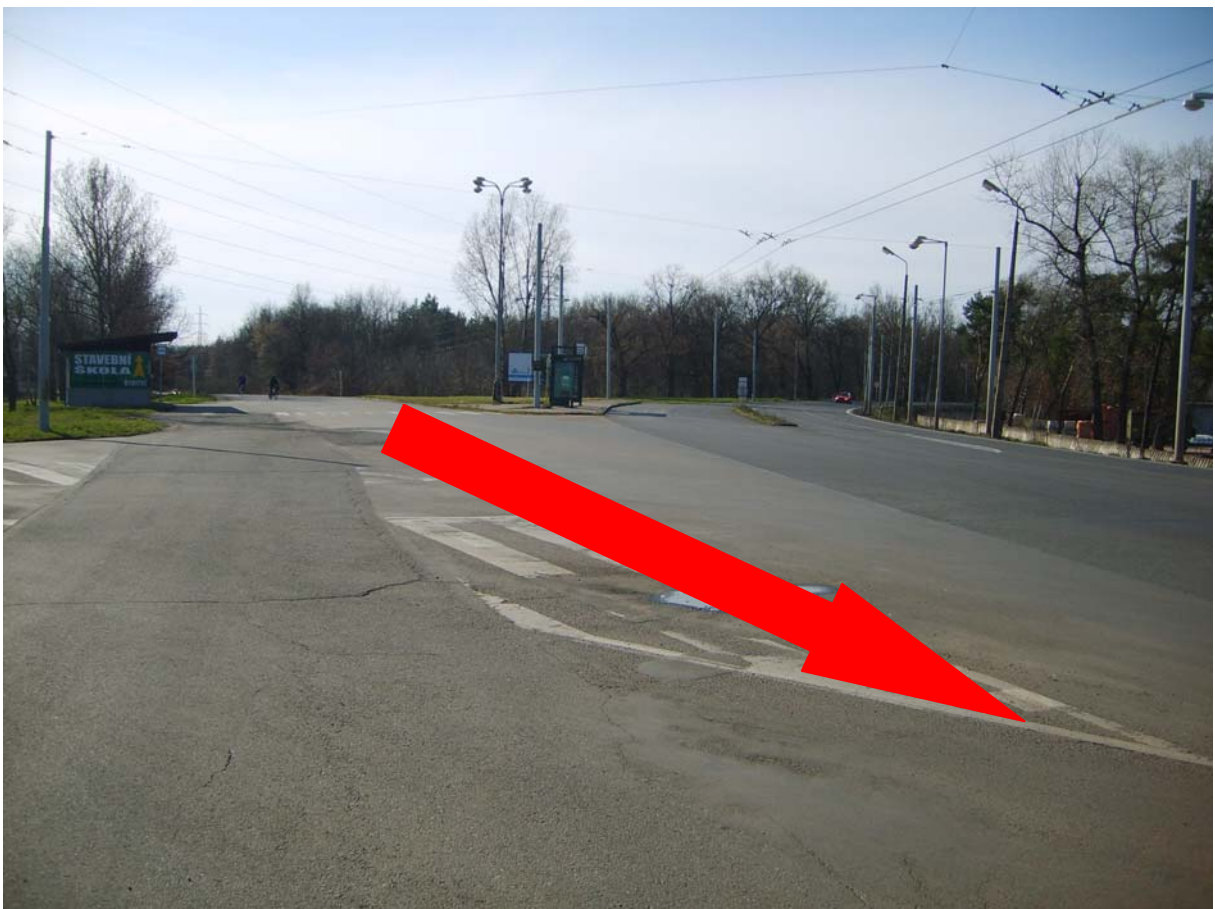
Obr. 20 Stávající stav – křížení I/36 s III/32225
