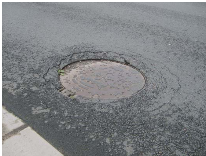
Obrázek 5 – Stav nové vozovky v ul. Šípkova okolo poklopu kanalizace (II)
