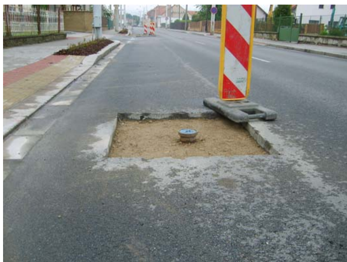
Obrázek 6 – Oprava nové vozovky v ul. Šípkova okolo krytu vodovodu
