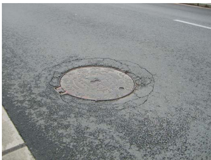
Obrázek 6 – Oprava nové vozovky v ul. Šípkova okolo krytu vodovodu
