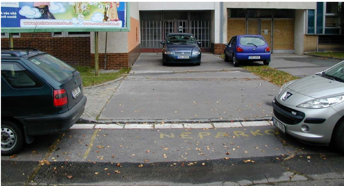
Obrázek 19: Neplatné vodorovné dopravní značení
