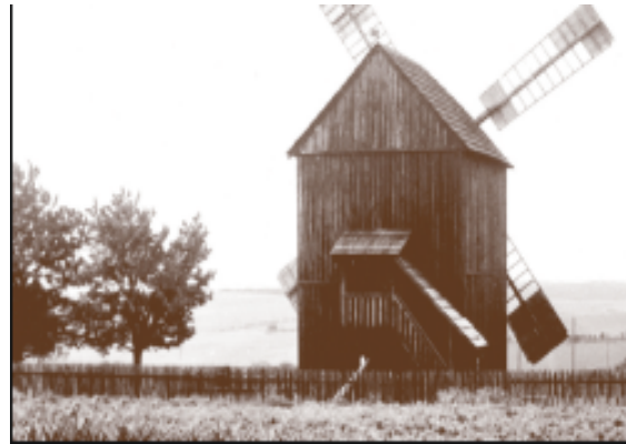
Obrázek 8 Sloupový větrný mlýn
