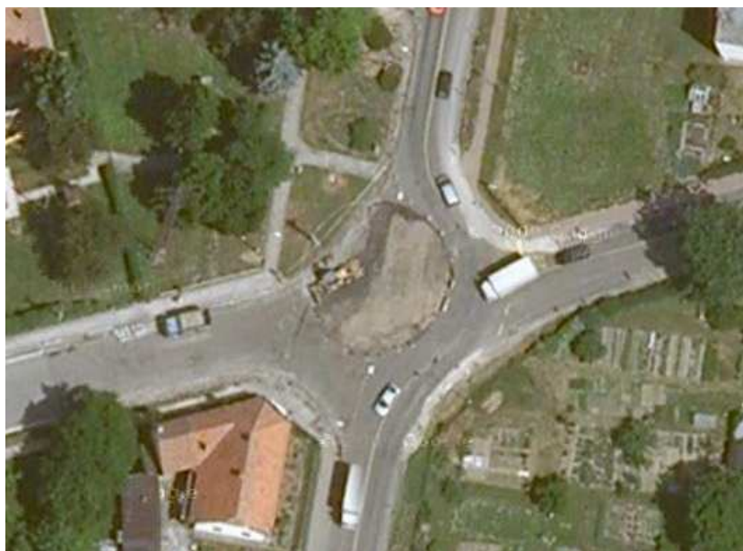
Obrázek 21: Pohled na křižovatku v době počátku přestavby [zdroj: 18]
