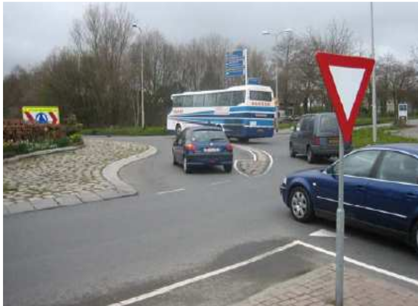
Obrázek 14: Detail stavební úpravy křižovatky v místě dvoupruhového vjezdu (Lisse-Keukenhof, Nizozemsko). [zdroj: 2]
