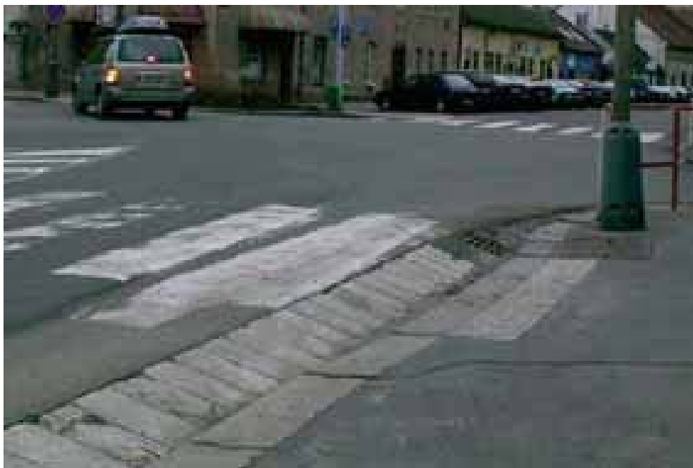
Obrázek 2 - Chybné řešení bezbariérovosti 1 (Zdroj: [2])
