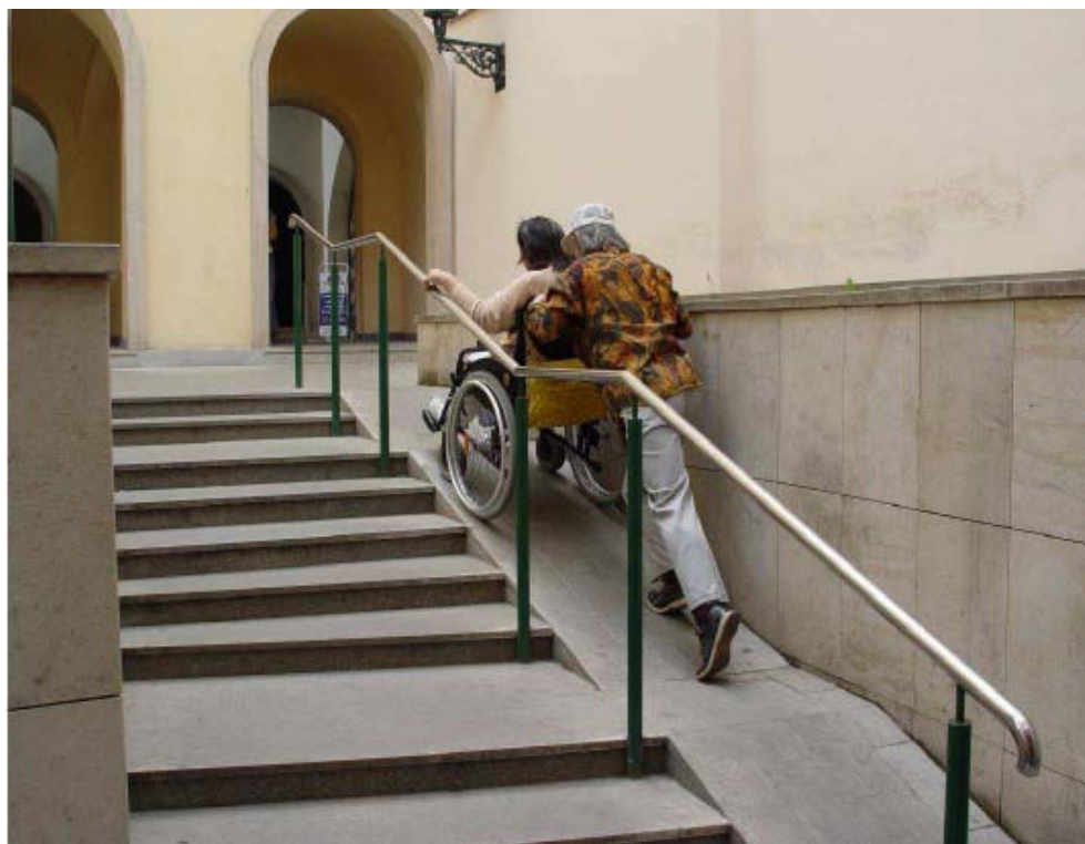
Obrázek 4 - Chybné řešení bezbariérovosti 3 (Zdroj: [33])
