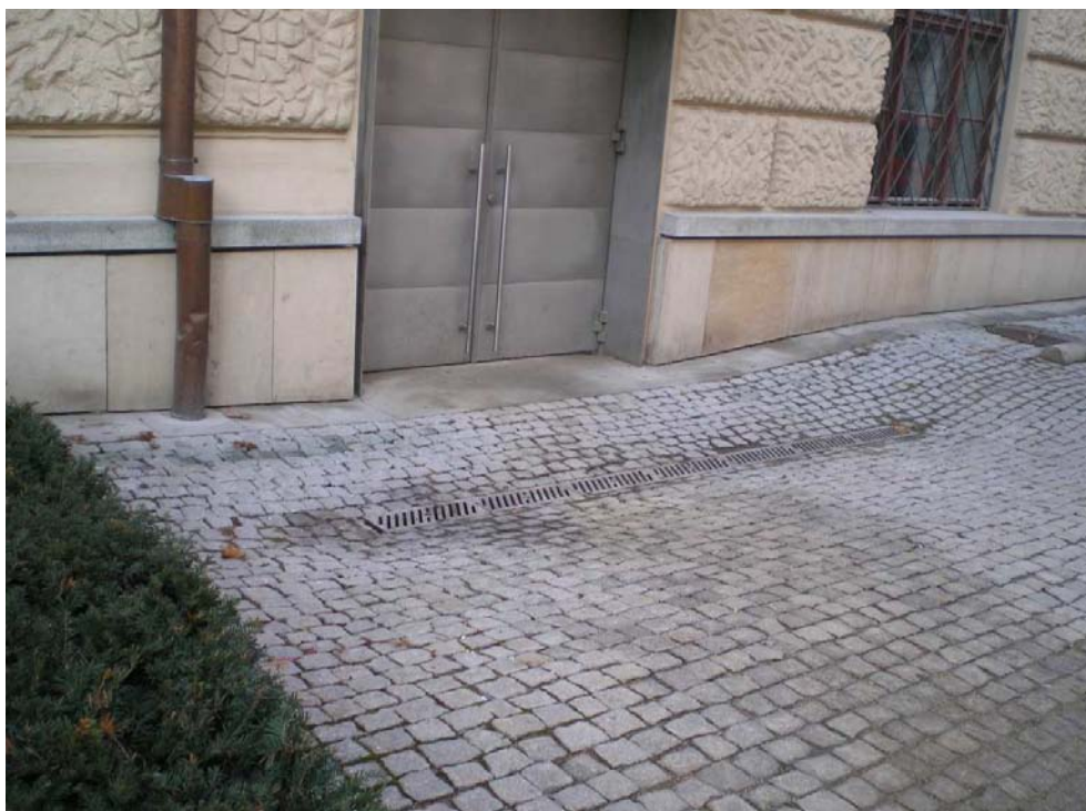
Obrázek 3 - Chybné řešení bezbariérovosti 2 (Zdroj: [42])
