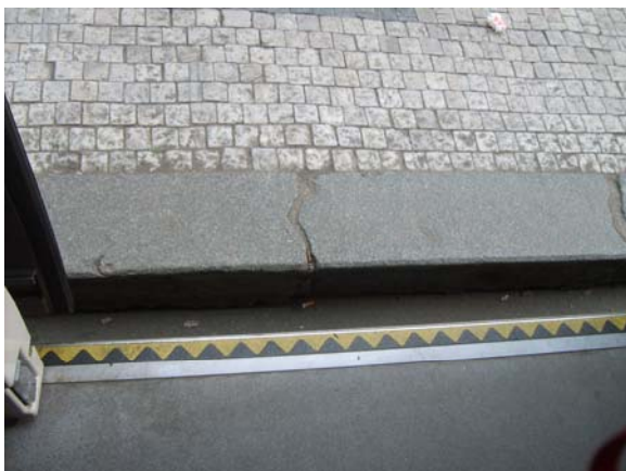
Obrázek č. 18: Mezera mezi nástupní hranou a vozem tramvaje T14
