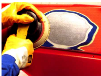
Obrázek č.6: Opravné práce – rozbroušení excentrickou bruskou [4]
