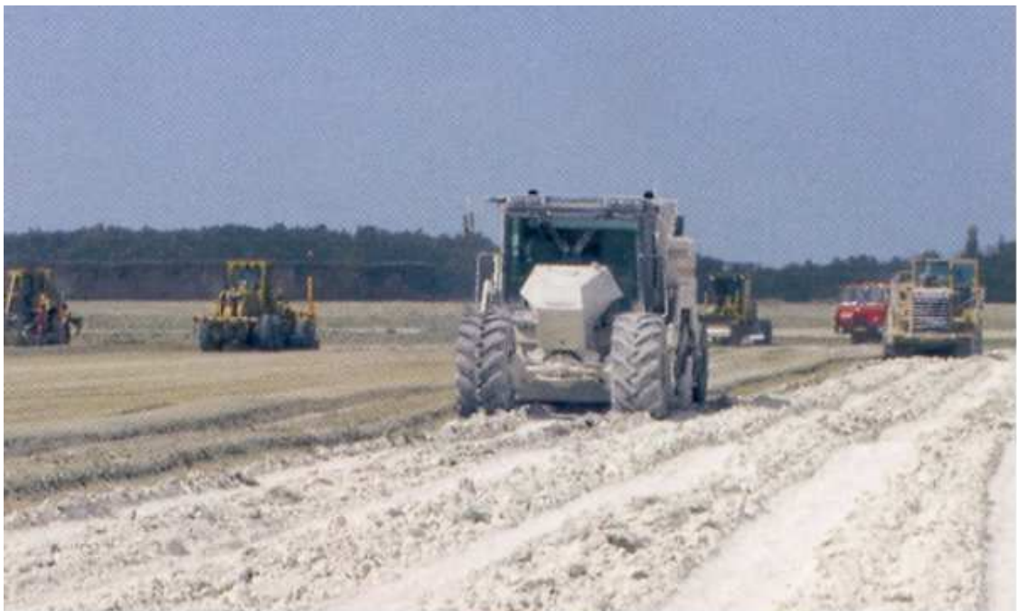
Obrázek 3-1: Mísení zeminy s hydraulickým pojivem [4]
