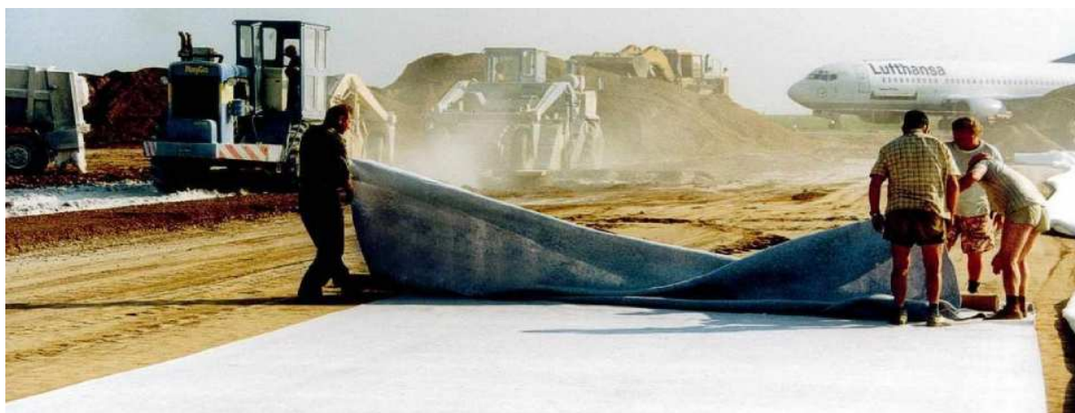
Obrázek 3-4: Pokládka filtrační a separační geotextilie na zemní pláň [9]
