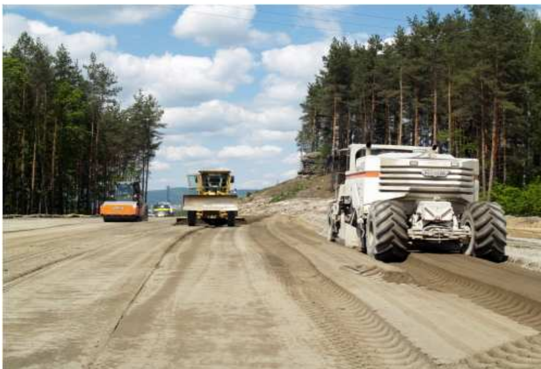
Obrázek 3-2: Mechanizace pro úpravu stabilizovaných vrstev [5]
