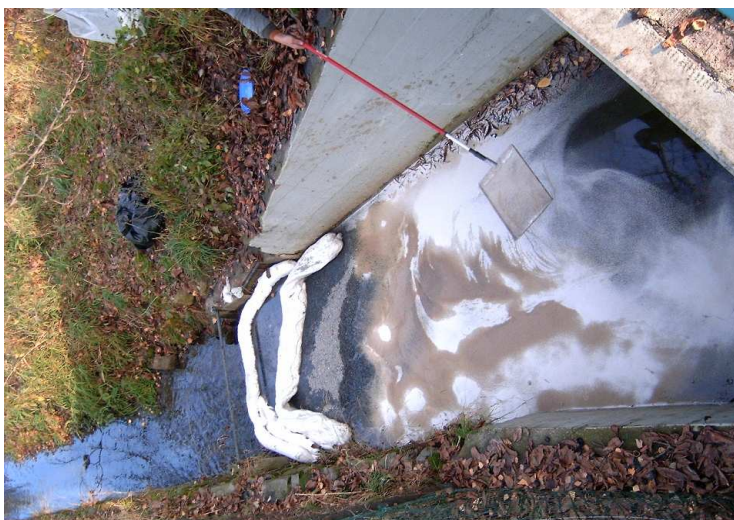
Obrázek č.17: Odstraňování Vapexu [13]
