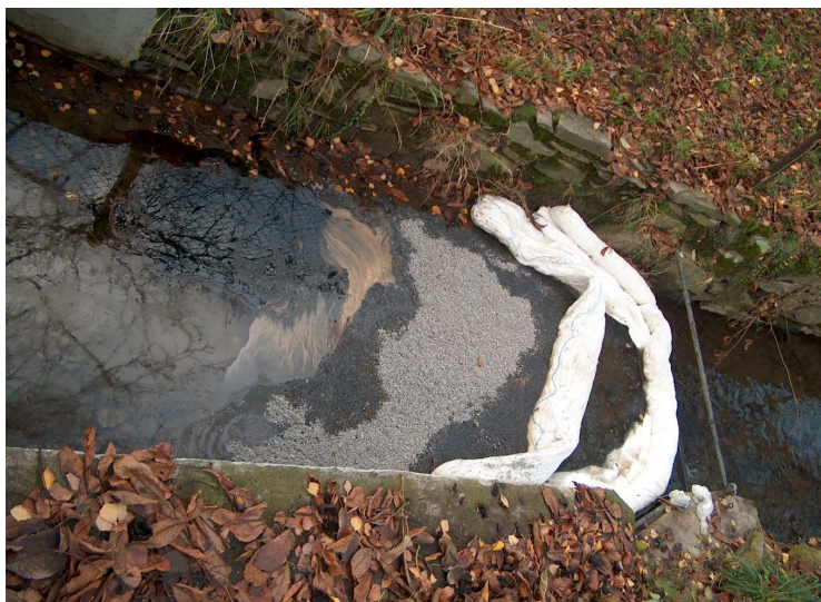
Obrázek č. 5 Instalace sorpčního hadu. Před stěnami je nasypán sorpční materiál (Vapex) [13]
