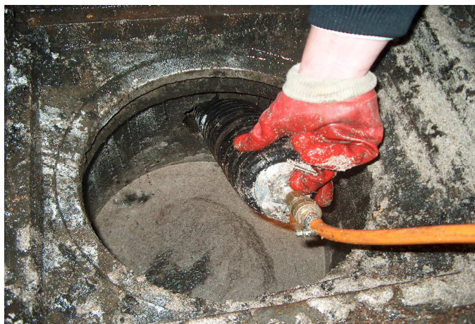
Obrázek č. 6: Ucpání potrubí mezi šachtou a bezejmenným potokem [13]
