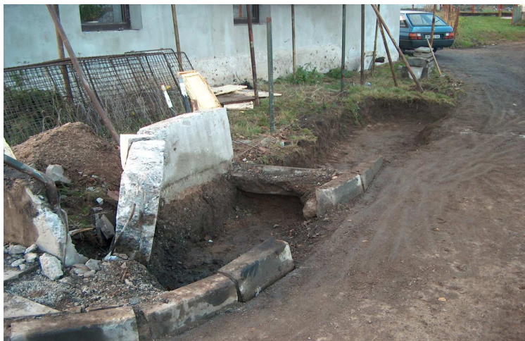
Obrázek č. 14: Výkop 1 [13]
