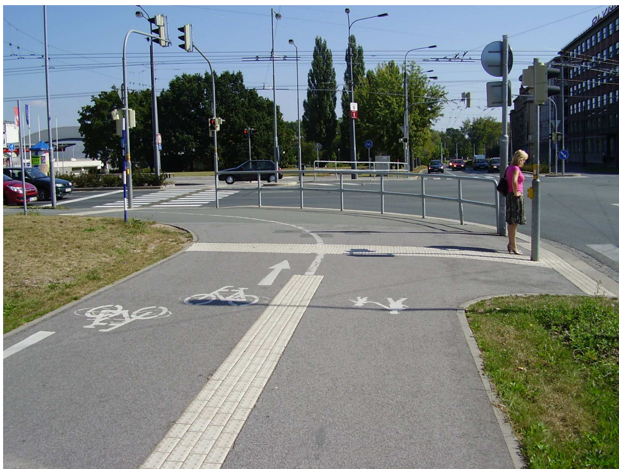
Obr. 1. 16 Současný stav – nevhodné ukončení hmatového pásu. Nevhodné vedení signálního pásu přes stezku pro cyklisty
