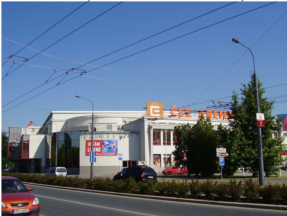
Obr. 1. 3 Pohled na zimní stadion v blízkosti křižovatky
