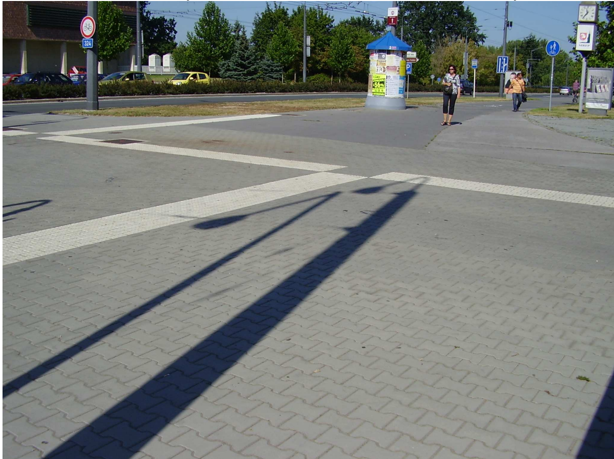
Obr. 1. 9 Odstranění dlažby – viz výkresová část: Situace bouracích prací
