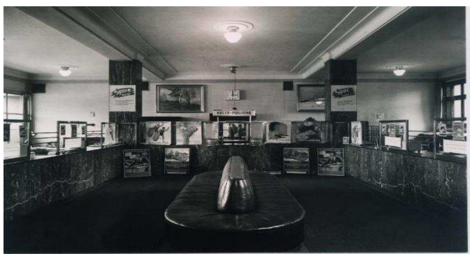
Obr. č. 7 Interiér knihovny v roce 1950
