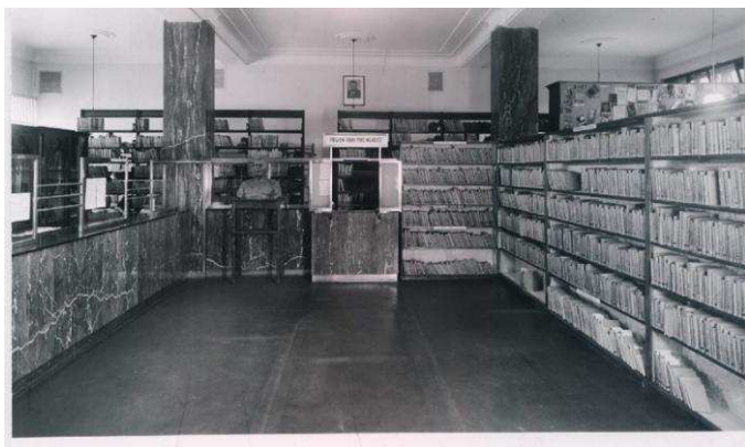
Obr. č. 8 Interiér knihovny v roce 1952
