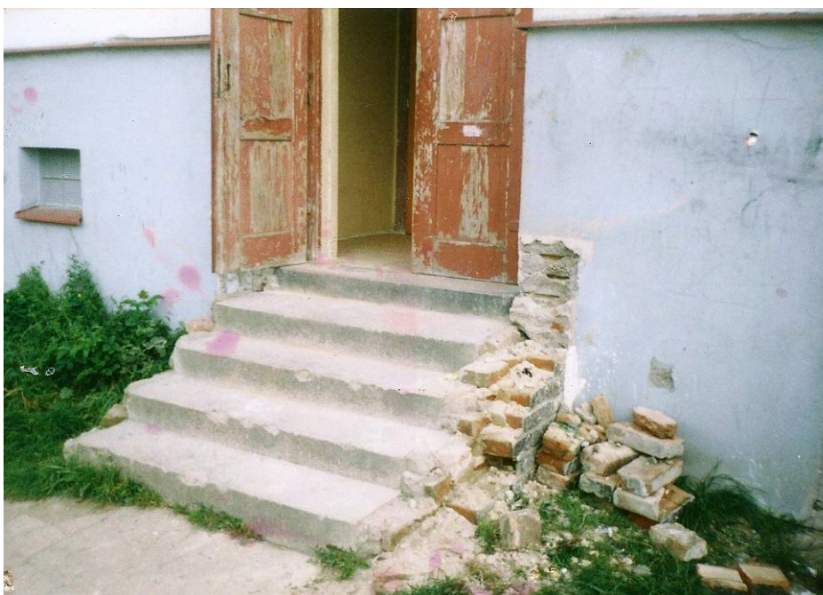
Obrázek 7 Vchod domu před rekonstrukcí
