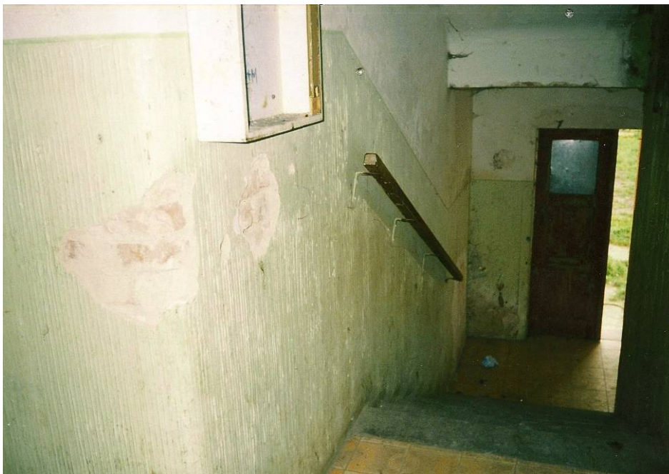
Obrázek 2 Chodba jednoho z domů před rekonstrukcí
