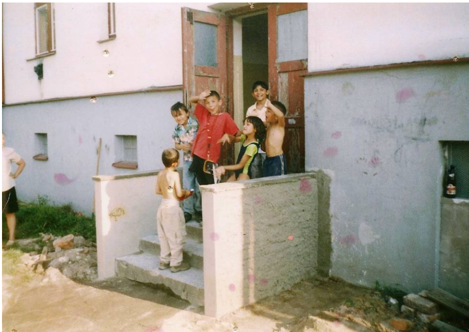
Obrázek 8 Děti pracující na rekonstrukci vchodu
