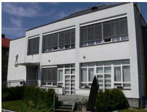
Obrázek č. 3 - Hlavní budova Geriatrického centra
