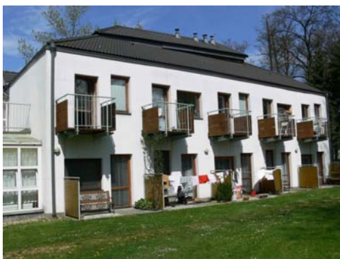
Obrázek č. 4 – Byty Domu s pečovatelskou službou
