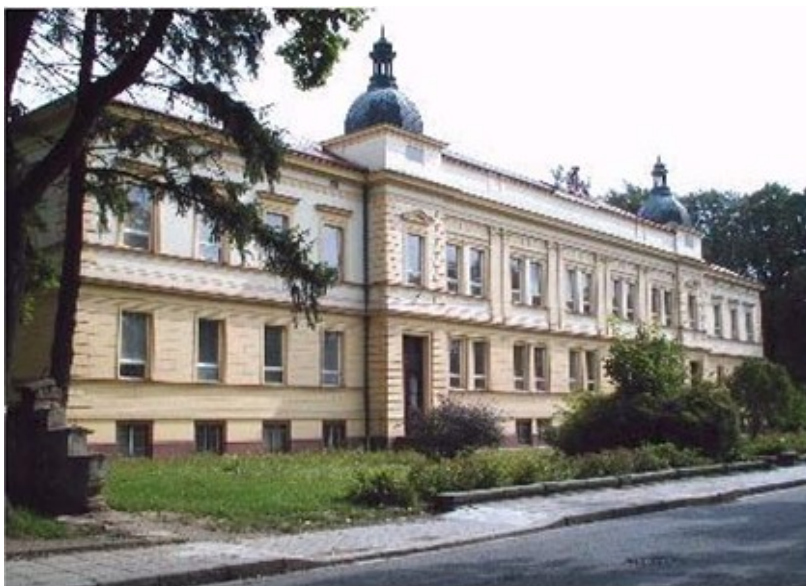
Obrázek č. 3: Budova Základní školy na ulici Riegrova ve Svitavách
