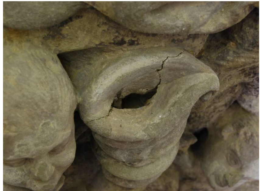
Odstraňování železných armatur, lepení rohu hojnosti.
