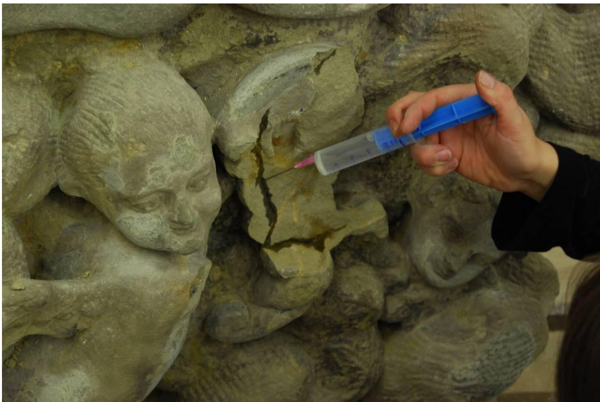
Injektáž 7,5 % roztokem Paraloidu B72 v xylenu.
