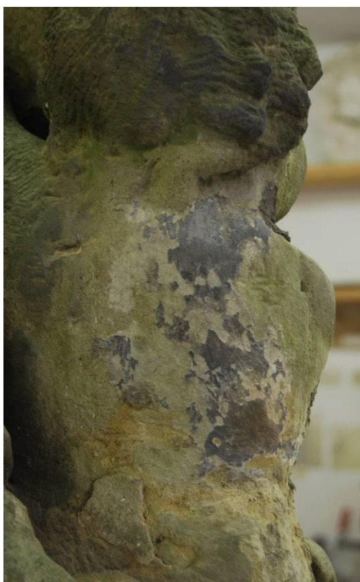
Mechanické čištění sádrovcových krust.
