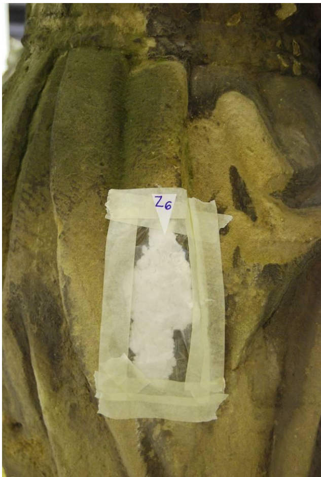
Odstraňování sádrovcových krust pomocí uhličitanu amonného.
