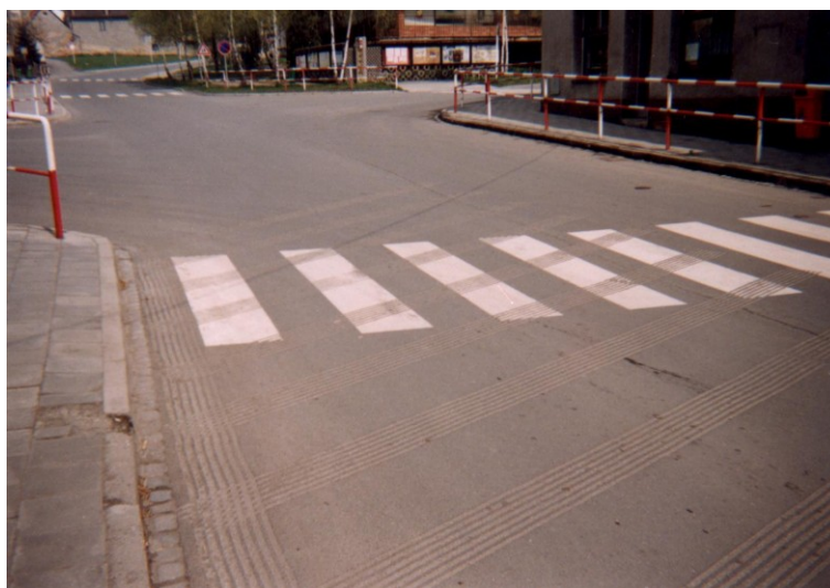
Obr.53. Bezhluchný odvodňovací profil aplikovaný na místní komunikaci
