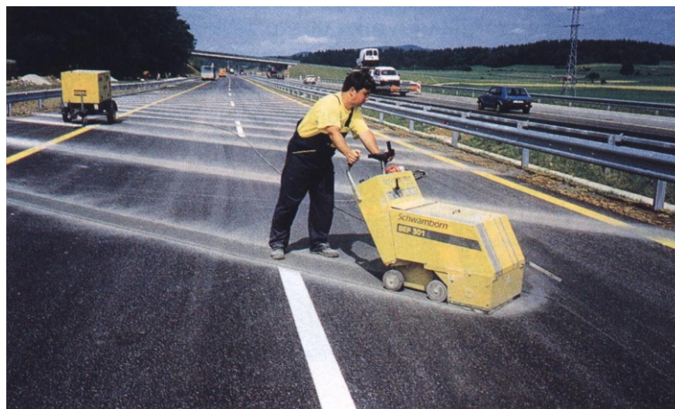
Obr.16. Použití radiální frézy Schwamborn BEF 301 [113]
