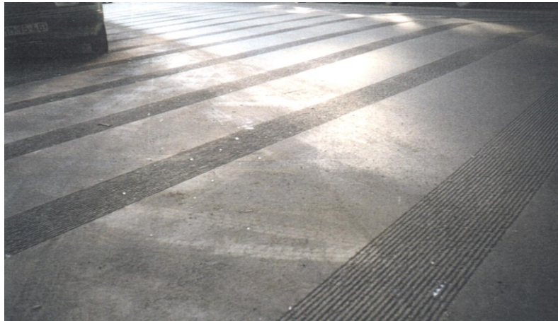
Obr.15. Bezhluchný odvodňovací profil aplikovaný na parkovací ploše
