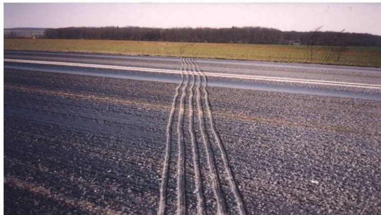
Obr.14. Bezhlukový odvodňovací profil aplikovaný na vícepruhové komunikaci
