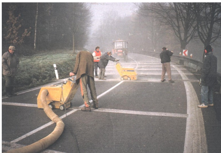
Obr.55. Frézování drážek za krátkodobé uzavěry provozu na silnici I.tř.
