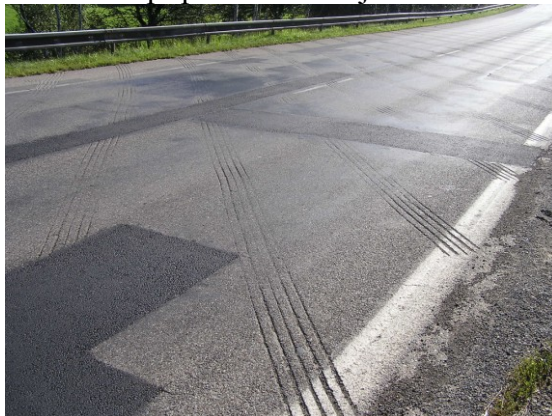
Obr.56. Opatření drážkování provedené na silnici I/34 mezi obcí Michalovice a Šmolovy okres Havlíčkův Brod
