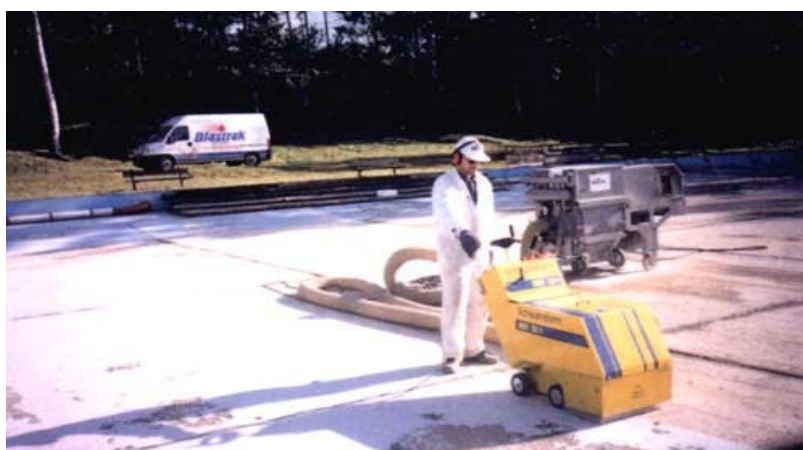
Obr.17. Radiální fréza Schwamborn BEF 301 s připojeným vysávacím zařízením [113]
