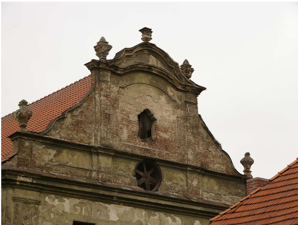
Obr. 10: Litomyšl – Nedošín, Štít sýpky tzv. Pernštejnského dvora. Foto: Vladislava Říhová.
