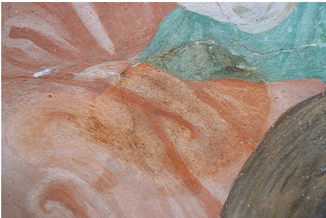
10. Stav po sejmutí retuše, izolace a ztenčení bituminózní skvrny.
