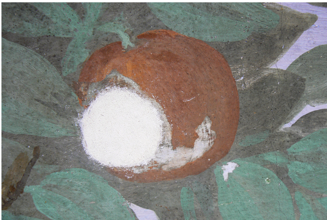
18. Stav po vymelení. Detail.
