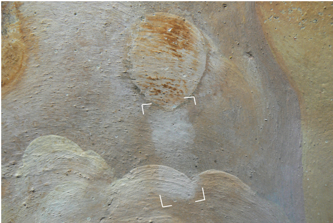
27. Zkouška čištění bituminózní skvrny zábalom z inertní papíroviny Arbocel a horké vody.
