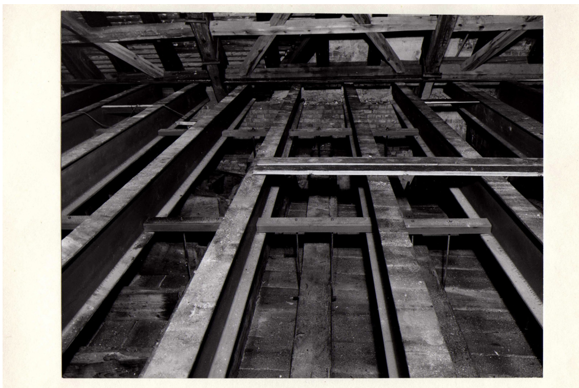
3. Pohled na klenbu sálu zavěšenou na ocelových traverzách před uchyťáváním fošen dřevěného podbití.
