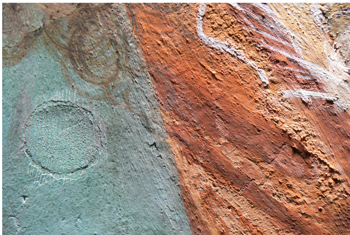
11. Sekundární tmel s nevyhovující strukturou a okraji a odlupující se barevná vrstva. Foto v razantním bočním osvětlení.
