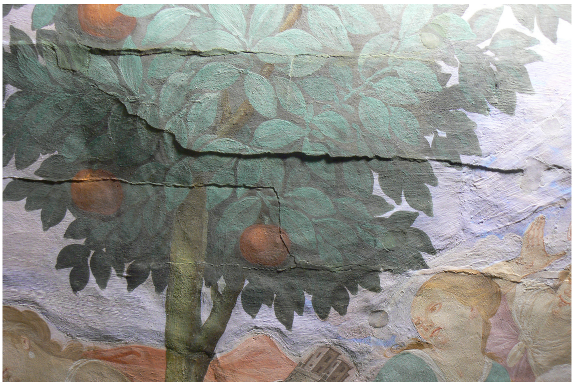
5. Tmelené horizontální praskliny způsobené v minulosti pohyby dřevěných fošen podbití malby. Tmely narušují homogenitu hladkého povrchu malby. Foto v razantním bočním osvětlení.
