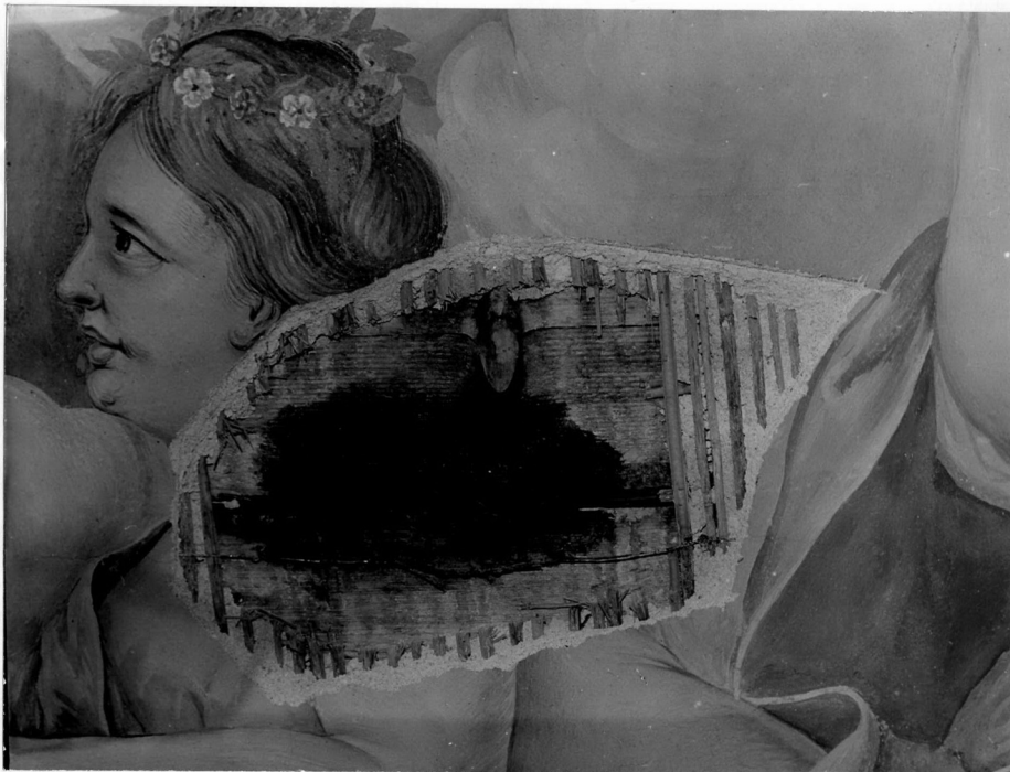
8. Omítka odstraněna. Dehtová izolace prosákla prkny stropu.
