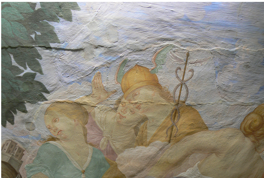
8. Tmelené horizontální praskliny způsobené v minulosti pohyby dřevěných fošen podbití malby. Tmely narušují homogenitu hladkého povrchu malby. Foto v razantním bočním osvětlení.
