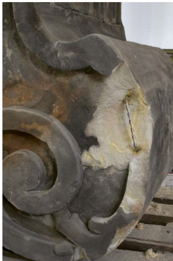
Obr. 81) Vyinjektovaná část s nerezovou kramlí pro lepší odolnost a trvanlivost rozsáhlejšího tmelu.
