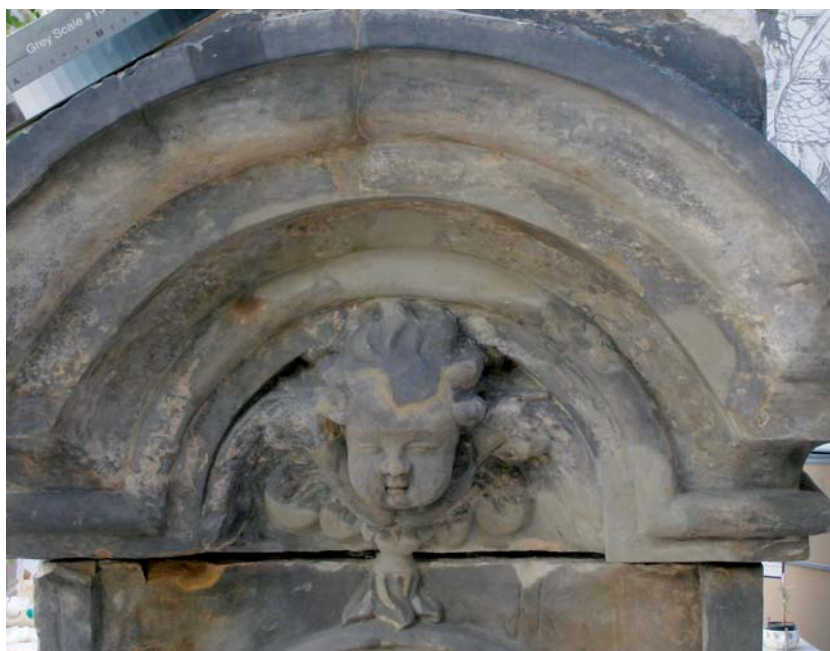
Obr. 98) Detail římsy a hlavy andílka po plastické retuši.
