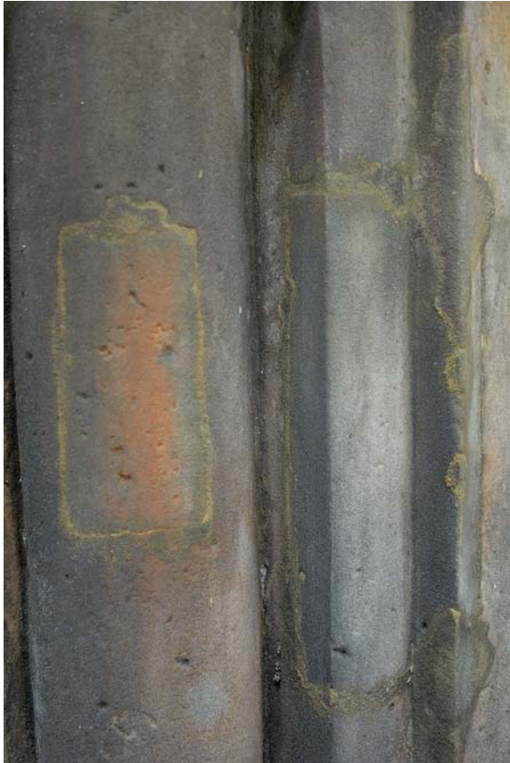
Obr. 75) Stav soklu před restaurováním. Detail zežloutlých starších tmelů, ohraničujících staré kamenné vložky.
