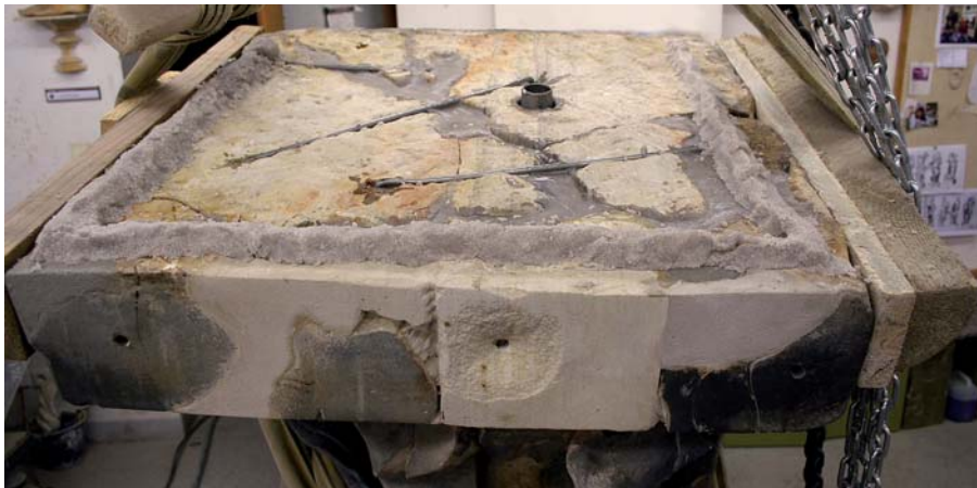
Obr. 26) Detail zalitých dutin v nitru kamene, pročepevání. Přípravná plocha na přilepení a natavení nerezového plátu.
