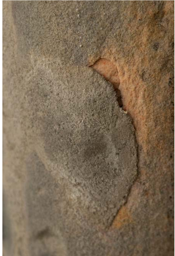
Obr. 76) Stav soklu před restaurováním. Detail zvětralého povrchu pod starším tmelem.
