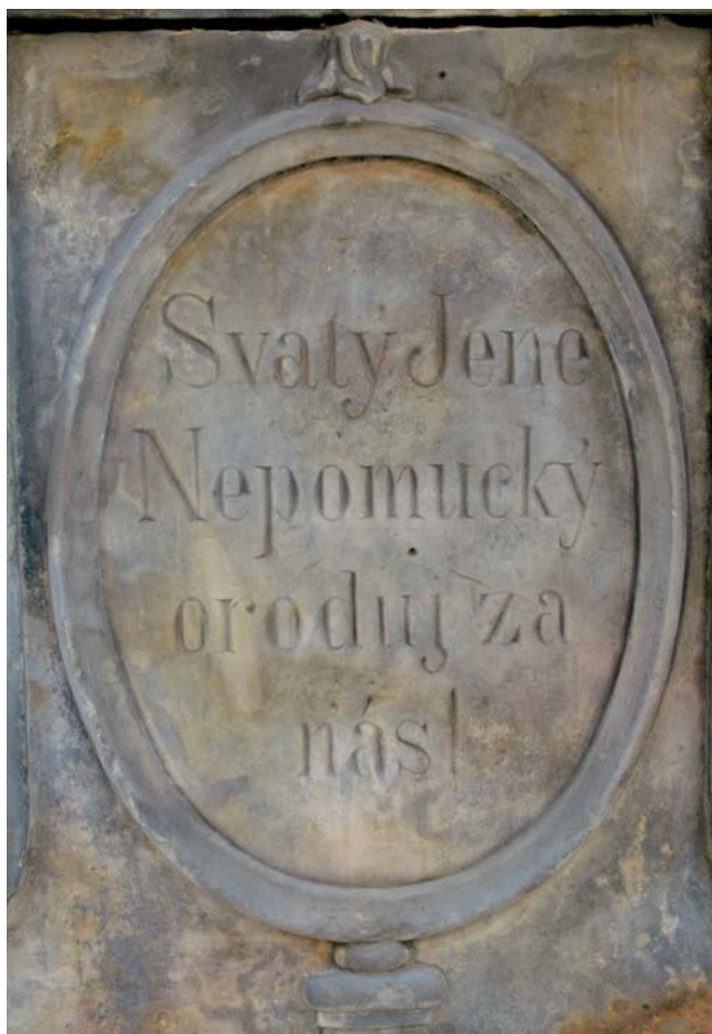
Obr. 100) Detail nápisové kartuše po plastické retuši a v průběhu barevné retuše.
