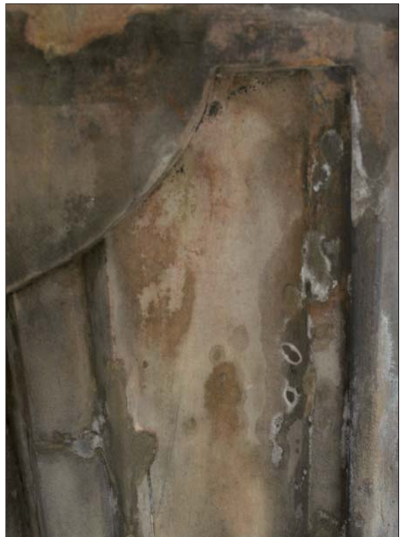
Obr. 78) Stav soklu před restaurováním. Detail starších tmelů s viditelnými bílými výkvěty solí na povrchu.
