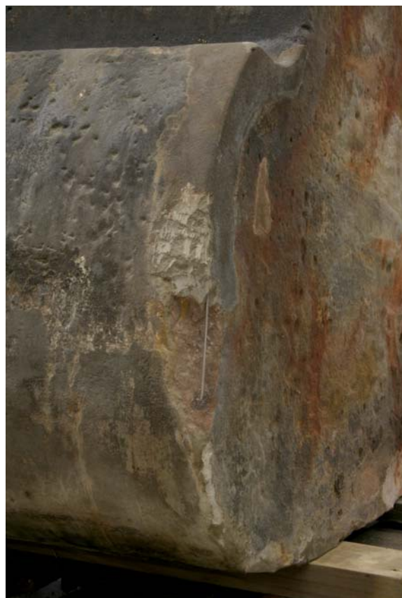
Obr. 86) Odsekání vydrolených částí tmelu.
