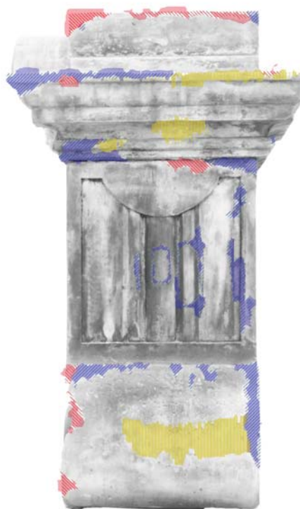
6) Zákres poškození na soklu. Boční pohled.
