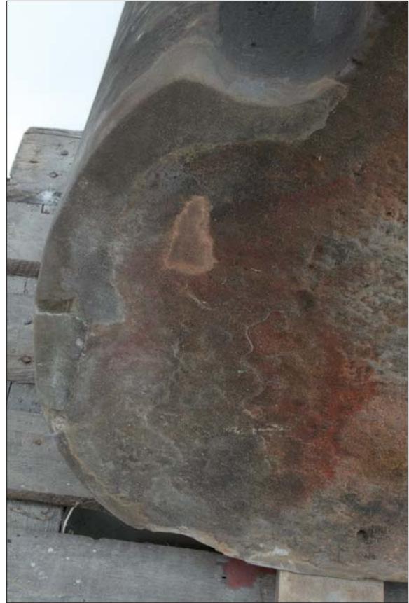
Obr. 72) Stav soklu před restaurováním. Detail zadní strany soklu se staršími tmely.
