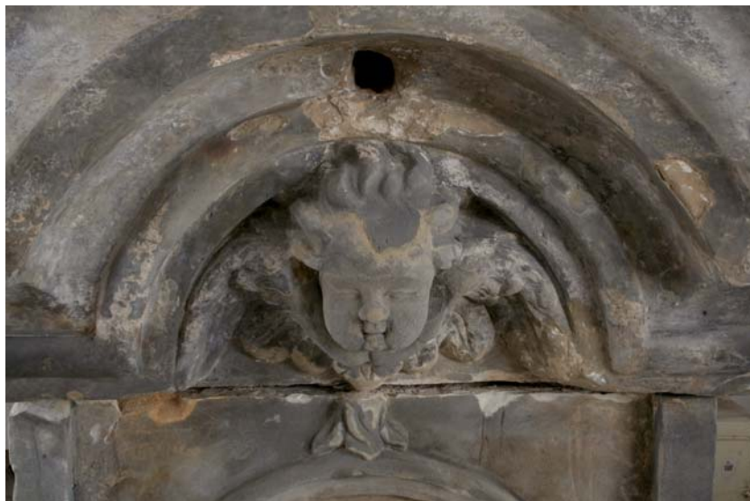
Obr. 97) Detail římsy a hlavy andílka po odstranění nevhodných starších tmelů.
