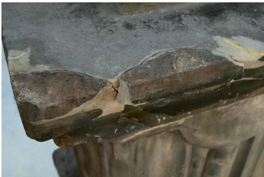
Obr. 90) Vyinjektované okolí dolepených úlomků, které byly následně po vytvrdnutí lepidla rovněž vyinjektovány.
