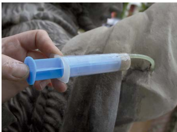
Obr. 59) Doinjektování menší dutiny mezi originálem a doplňkem nízkoviskózní epoxidovou pryskyřicí.
