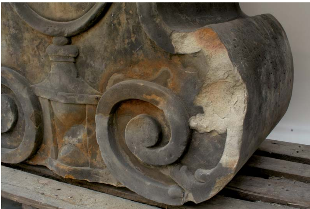
Obr. 79) Stav soklu před restaurováním. Detail části odlomené pádem na přední straně soklu vpravo dole.
