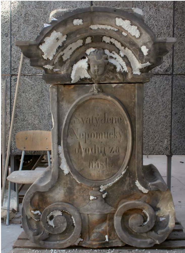
Obr. 95) Buničinový zábal 10% roztokem uhličitanu amonného na odstranění sádrovcových krust.
