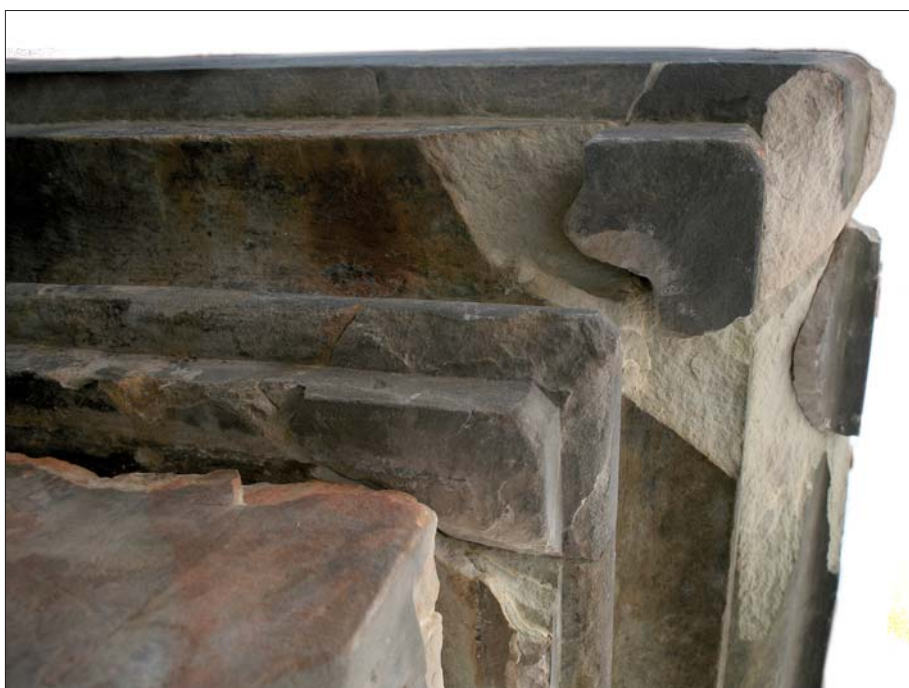
Obr. 89) Dolepené kusy na rohu soklu.
