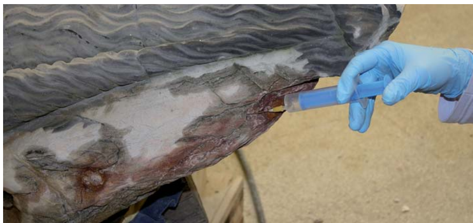
Obr. 23) Injektáž prasklin na čerstvém lomu kamene.
