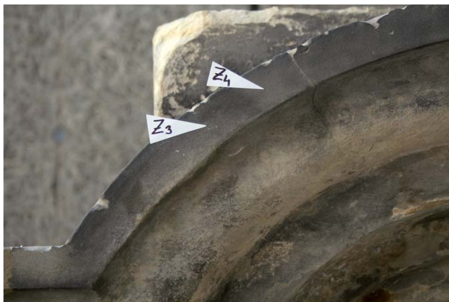
Obr. 93) Zkoušky čištění pomocí abrazivní metody mikropískování k odstranění silikátových nečistot.
