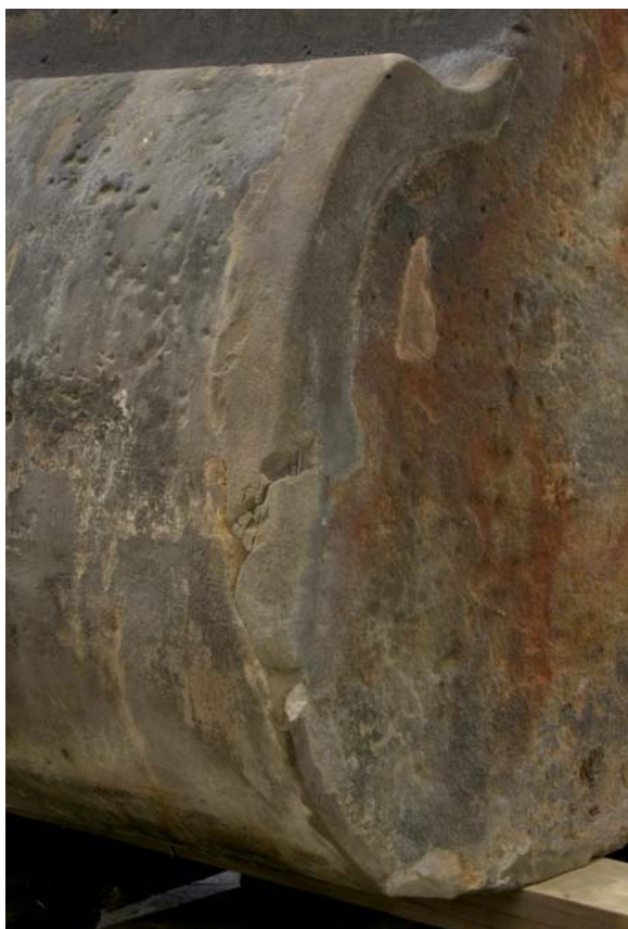
Obr. 85) Stav před restaurováním. Detail tmelu poškozeného pádem.
