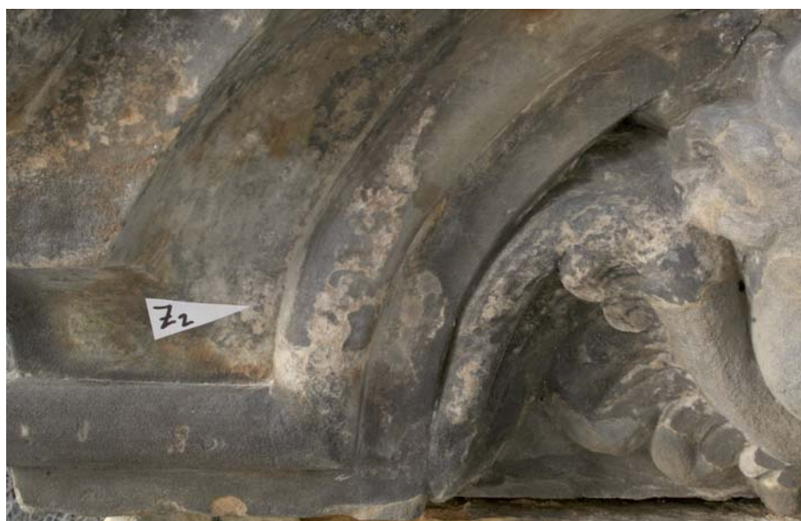
Obr. 92) Pozitivní výsledek zkoušky na odstranění sádrovcové krusty.
