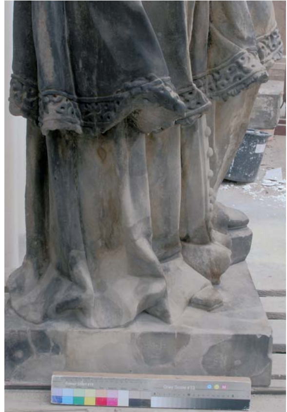
Obr. 40) Detail doplněné chybějící hmoty kamene po plastické retuši.
