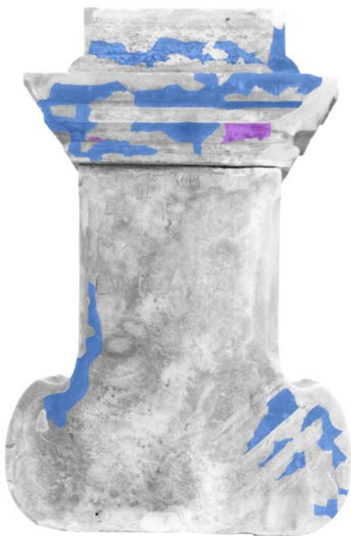
13) Zákres výskytu sádrovcových krust a silikátových nečistot na soklu. Zadní pohled.
