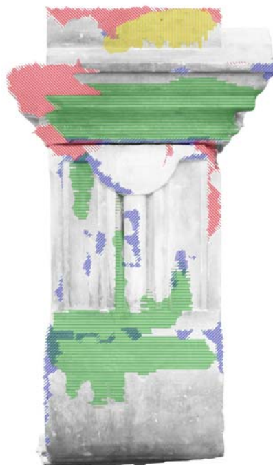
8) Zákres poškození na soklu. Boční pohled.
