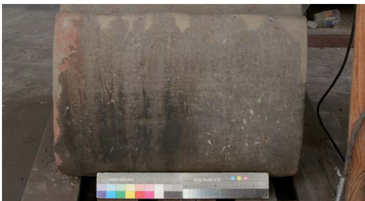
Obr. 96) Výsledek čištění pomocí abrazivní metody – mikropískování.
