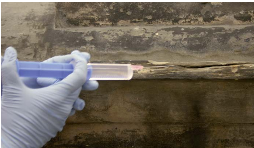
Obr. 84) Injektáž odhalené praskliny.
