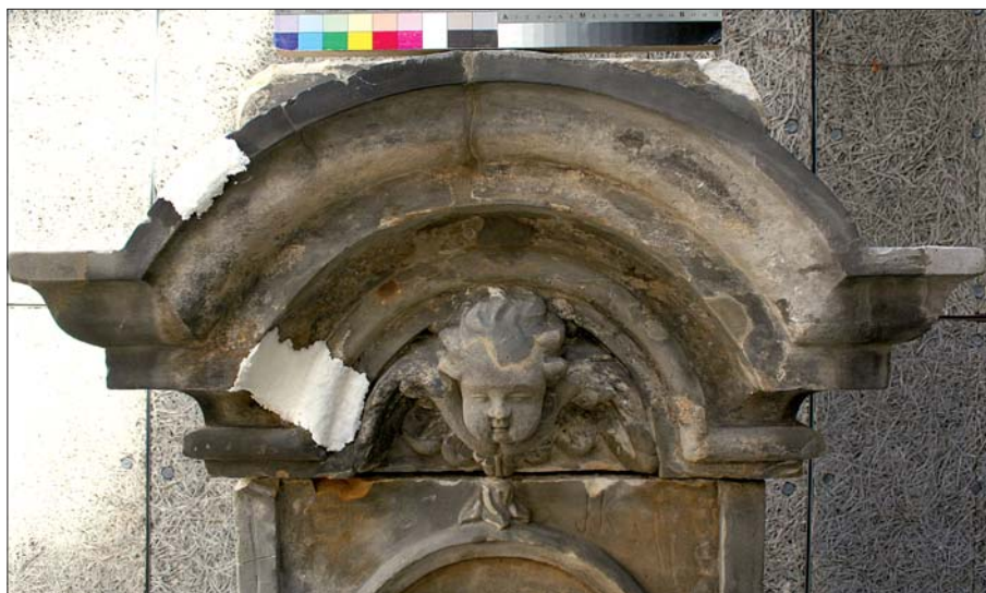
Obr. 91) Zkoušky čištění sádrovcových krust a silikátových povlaků.
