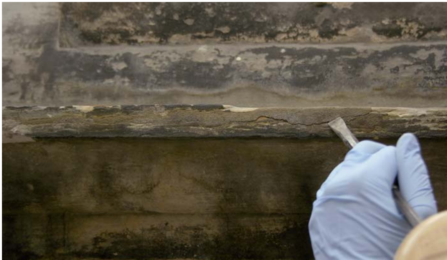
Obr. 83) Odstranění nevhodného staršího tmelu.
