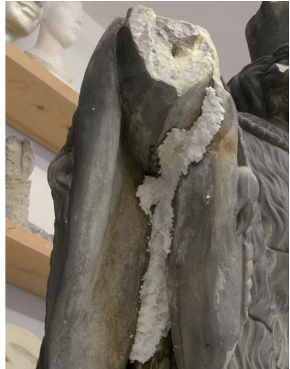
Obr. 45) Zábaly 10% roztokem uhličitanu amonného na odstranění sádrovcových krust.
