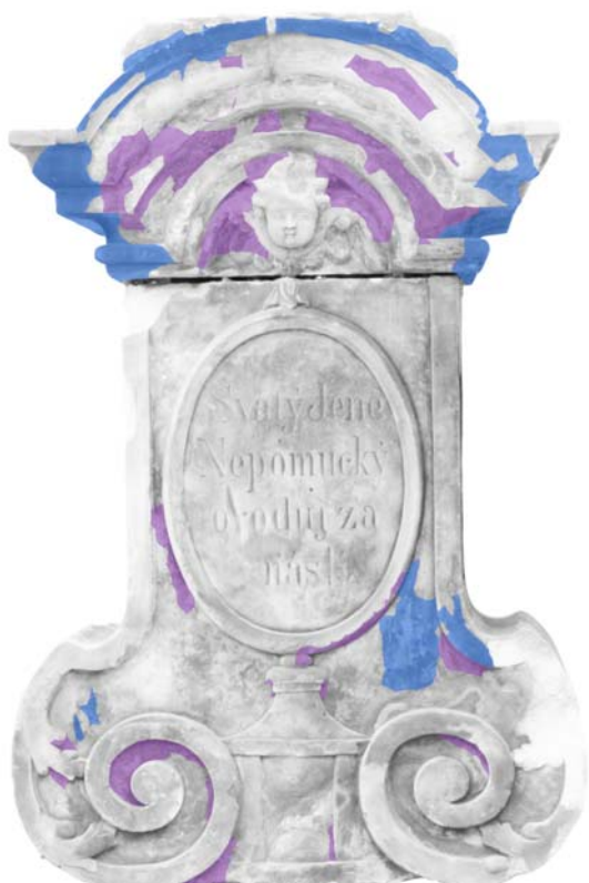
11) Zákres výskytu sádrovcových krust a silikátových nečistot na soklu. Čelní pohled.
