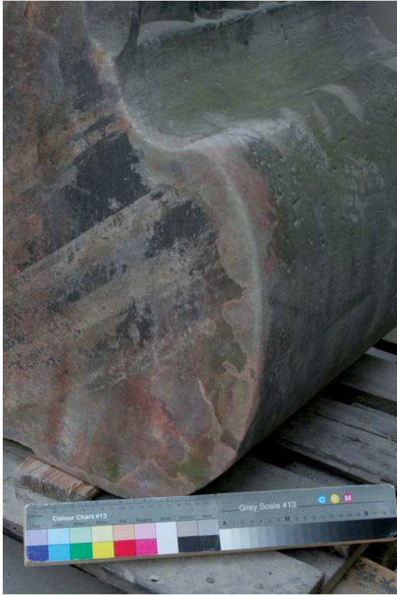
Obr. 71) Stav soklu před restaurováním. Detail zadního pravého rohu se staršími tmely a vrstvou silikátových nečistot.
