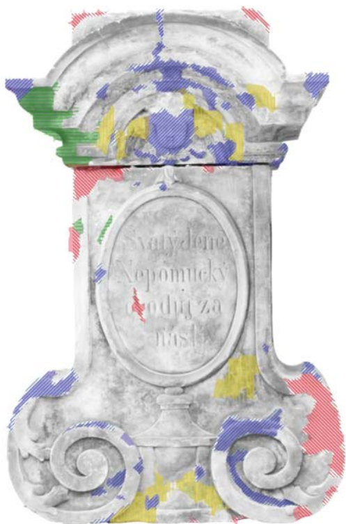
5) Zákres poškození na soklu. Čelní pohled.
