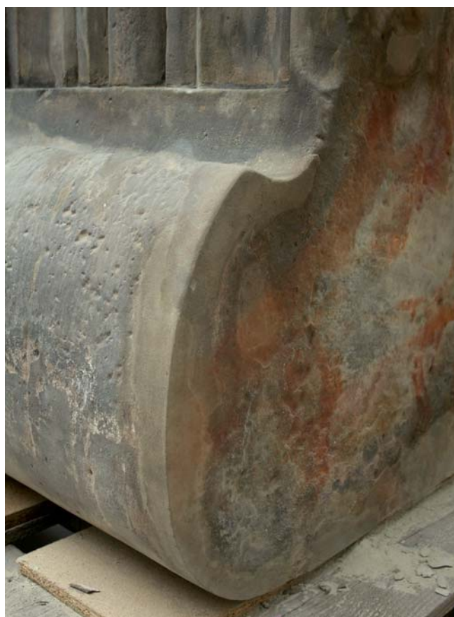
Obr. 87) Poškozený tmel po plastické retuši.
