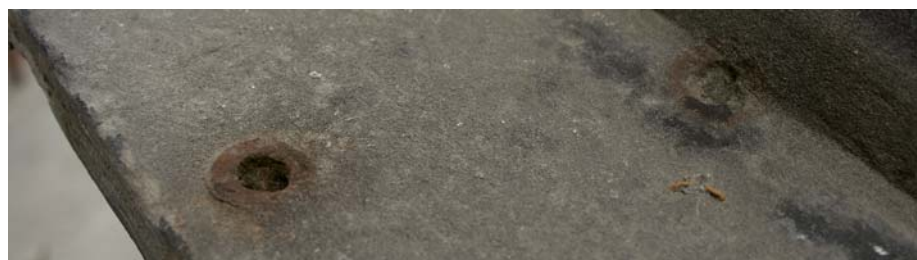
Obr. 74) Stav soklu před restaurováním. Detail s otvory po zmizelých hematitových brocích s rezavým okolím.
