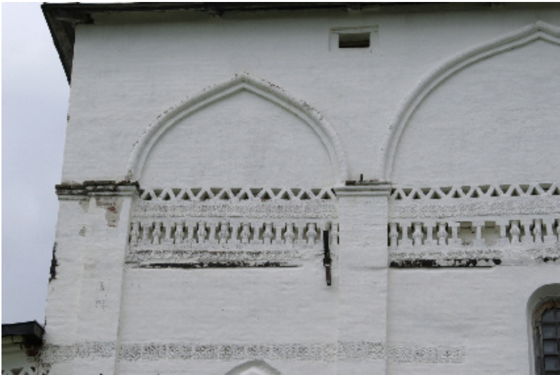
12. Severní stěna kostela Narození Panny Marie. Detail cihelného ornamentu po obvodu horní části stěn kostela.
