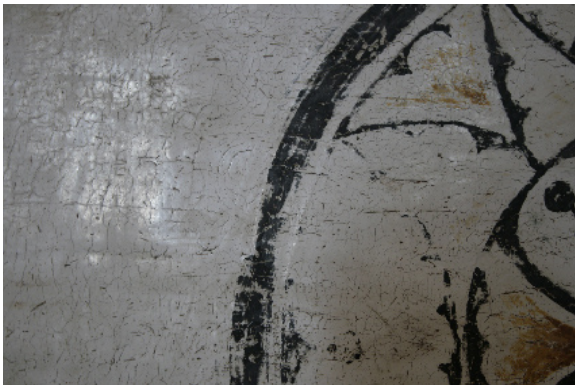
110. Brilantní povrch původního levkasu. Detail ornamentu ve spodním registru na západní stěně, zprava od vchodu.
