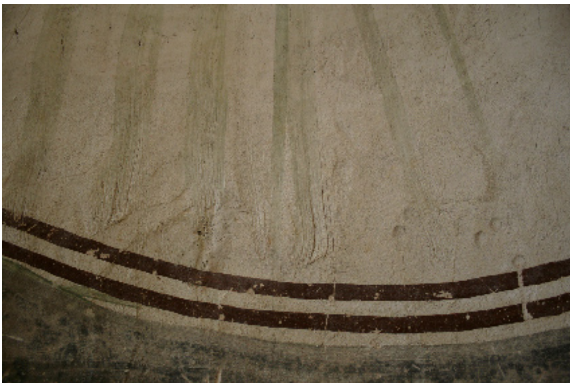
103. Stopy od štětců a prstů na místech nevyhlazené původní omítky. Severní stěna kaple svatého Mikuláše
