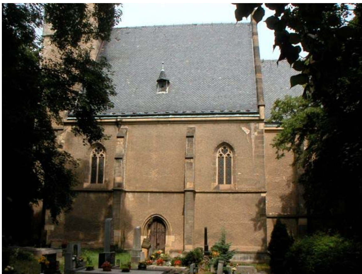
současný stav kostela – boční pohled
