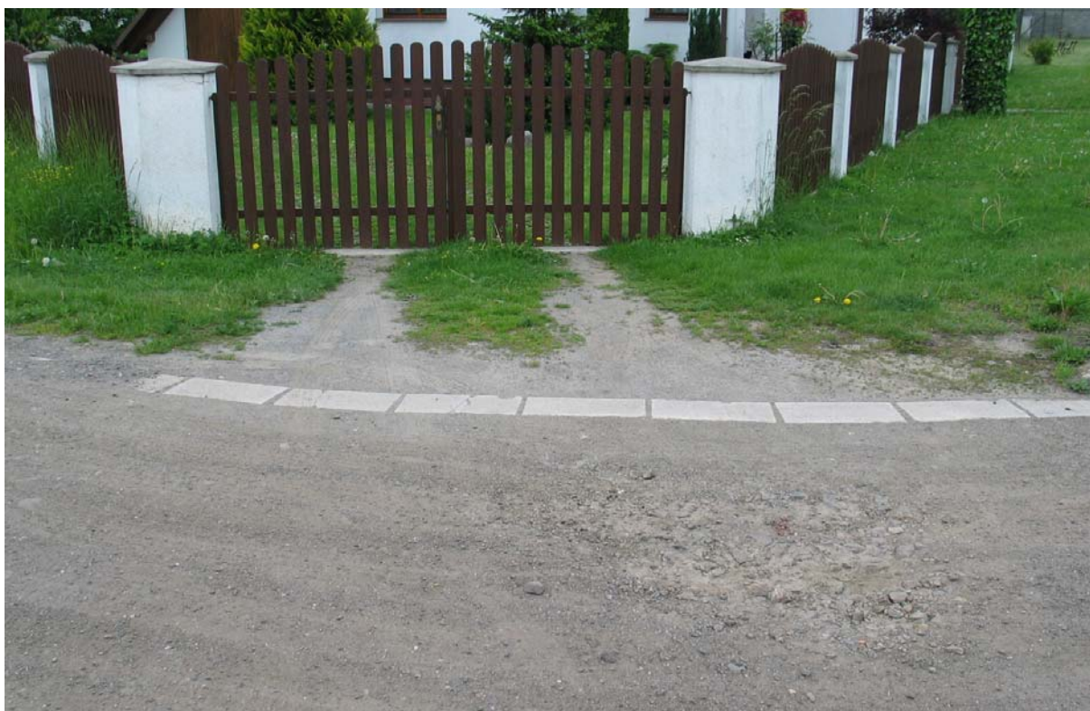
ÚROVNĚOVÁ KŘÍŽOVATKA – úsek “A“ vjezd na pozemk.parcelu č. 13/12, cca 115 m od z.ú. “A“
