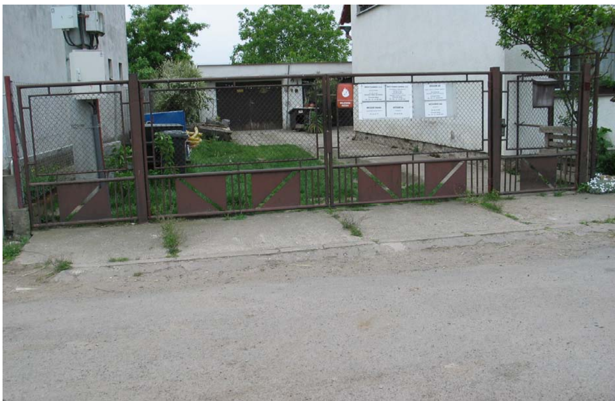
ZÓNA TEMPO 30 – úsek “A“ vjezd na pozemk. parcelu č. 179/3, cca 260 m od z.ú. “A“
