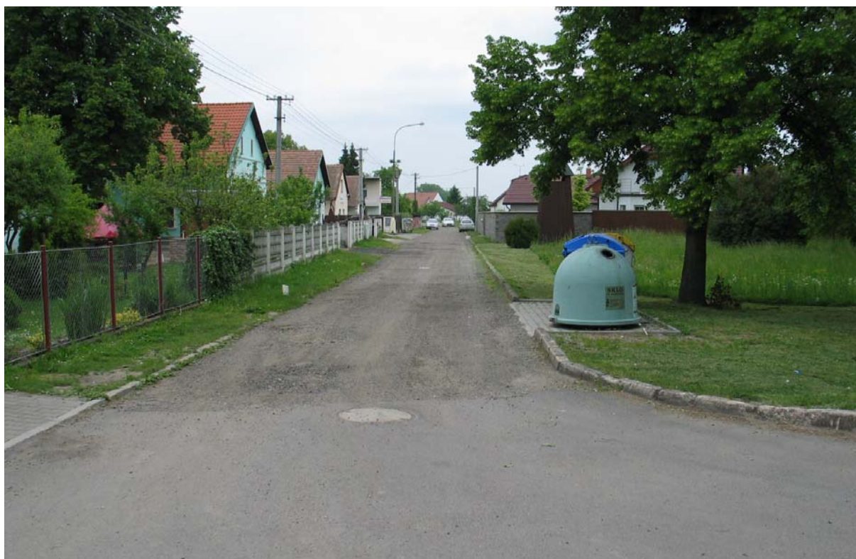
OBYTNÁ ZÓNA – úsek “B“ pohled ze silnice III/32232, z.ú. “B“
