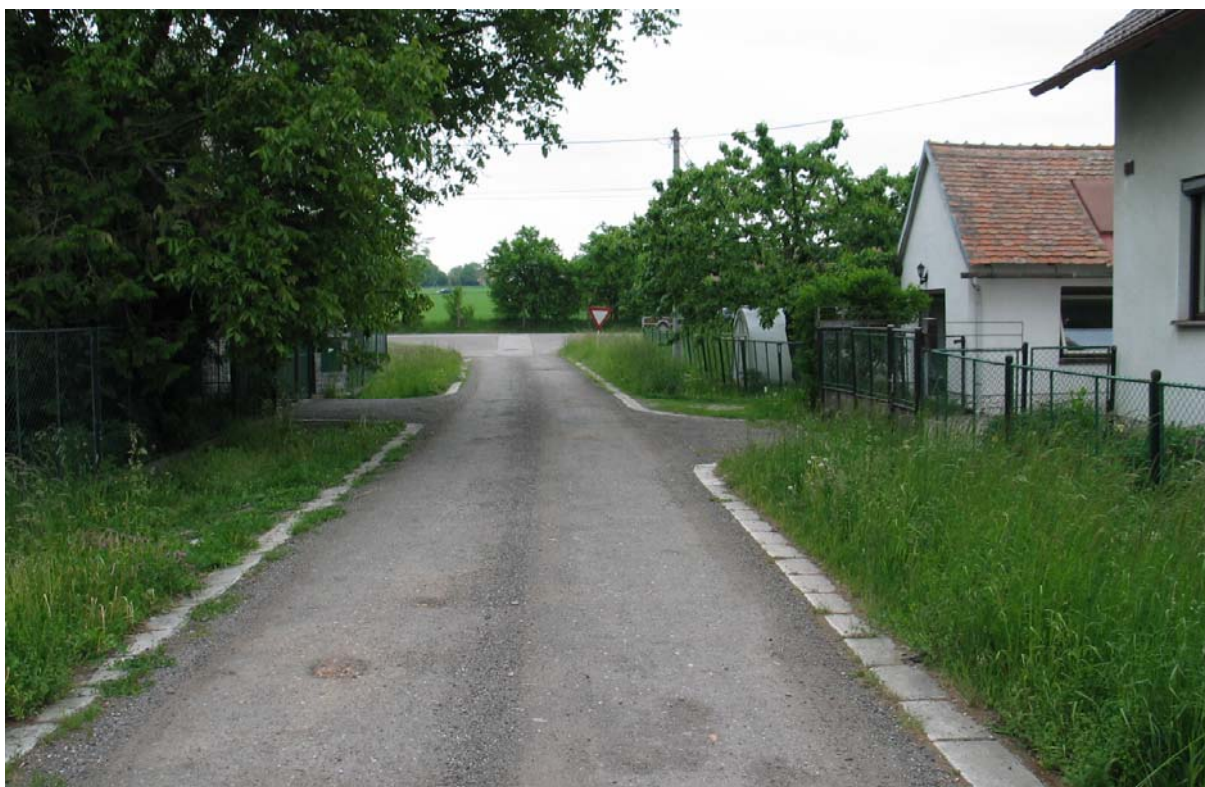
ZÓNA TEMPO 30 – úsek “A“ pohled zpět zónou TEMPO 30, cca 55 m od z.ú. “A“
