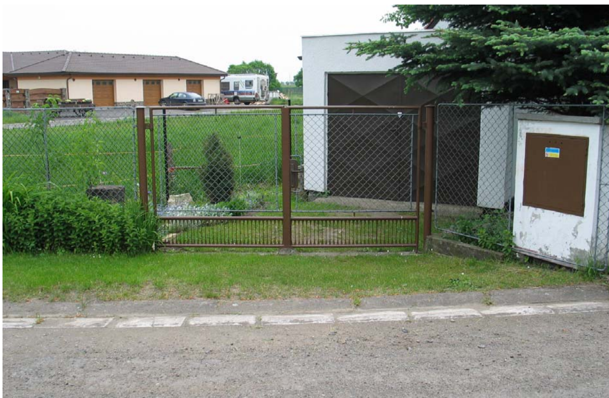
ZÓNA TEMPO 30 – úsek “A“ vjezd na pozemk. parcelu č. 14/8, cca 200 m od z.ú. “A“
