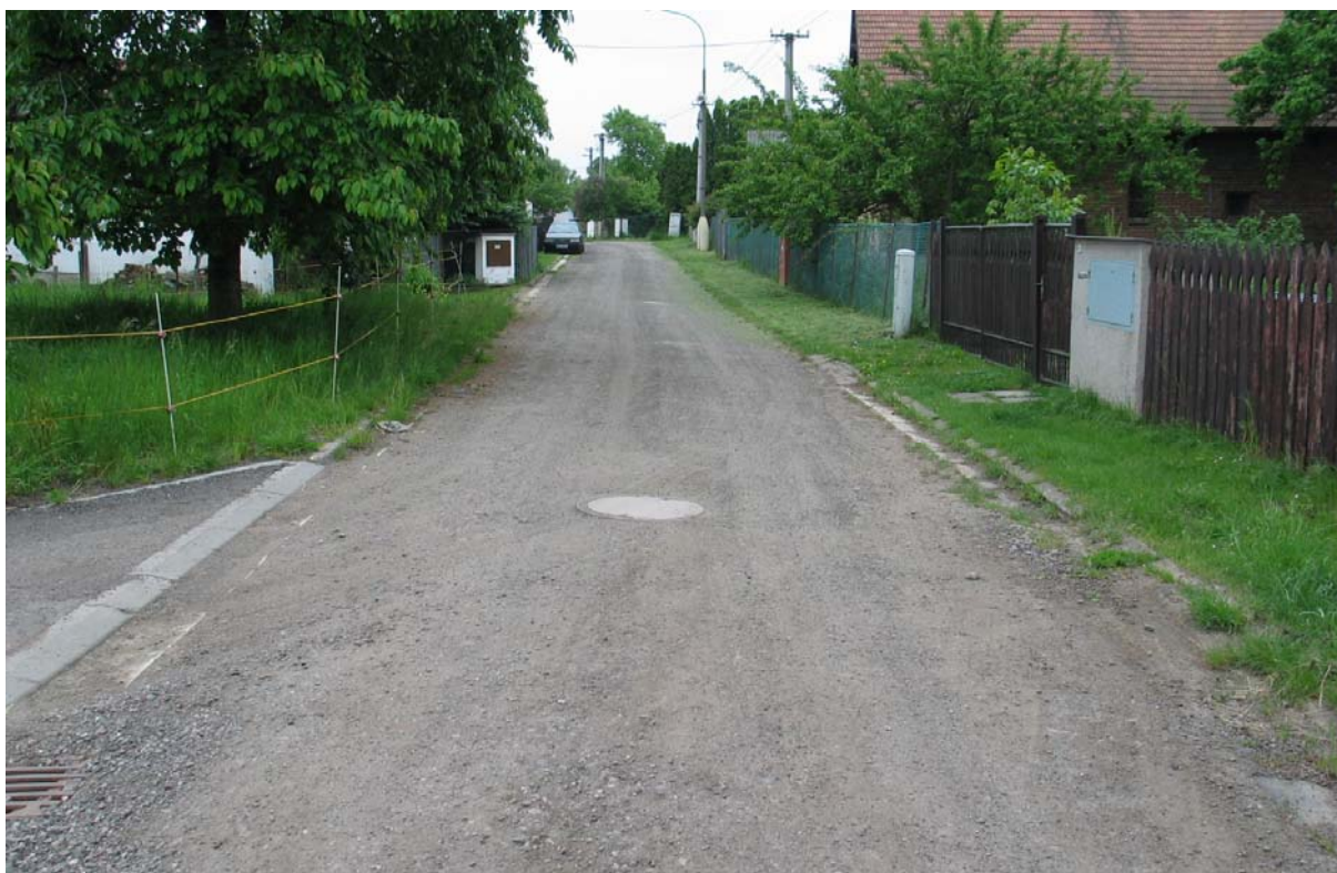
ZÓNA TEMPO 30 – úsek “A“ pohled zpět zónou TEMPO 30, cca 230 m od z.ú. “A“
