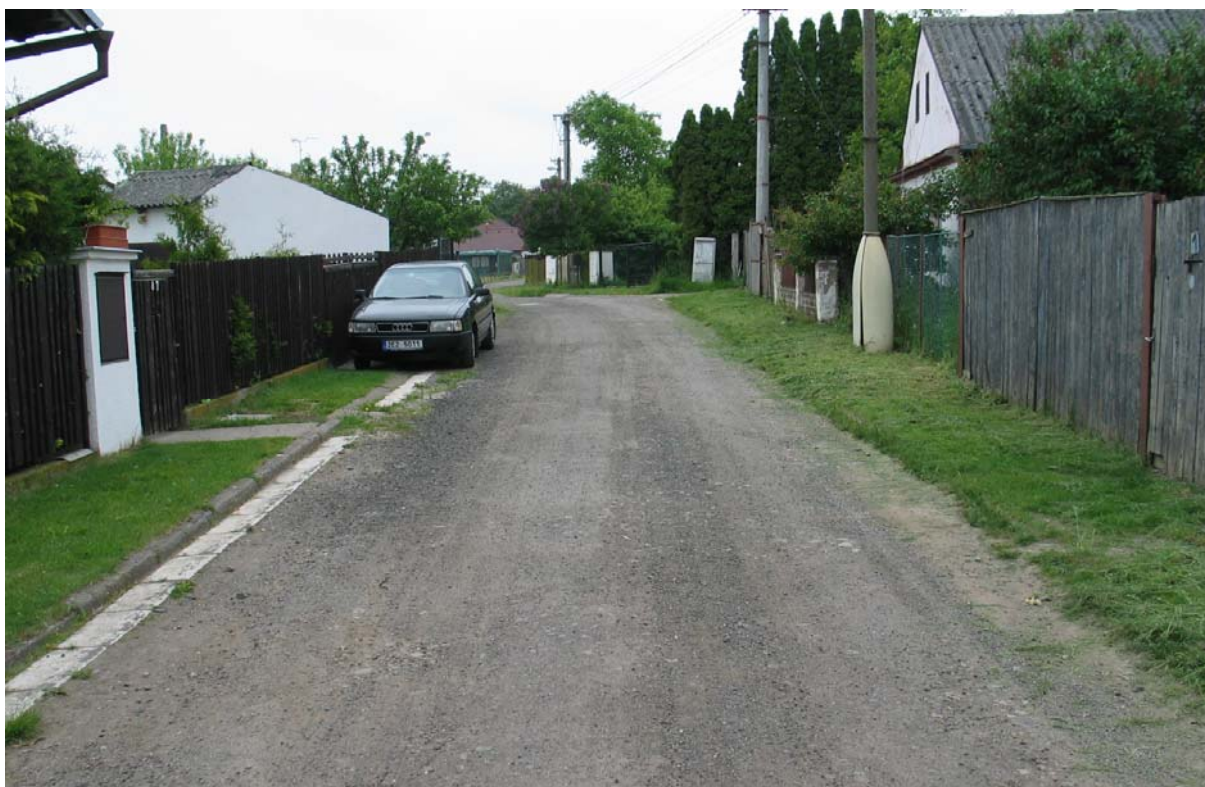
ZÓNA TEMPO 30 – úsek “A“ pohled zpět zónou TEMPO 30, cca 190 m od z.ú. “A“
