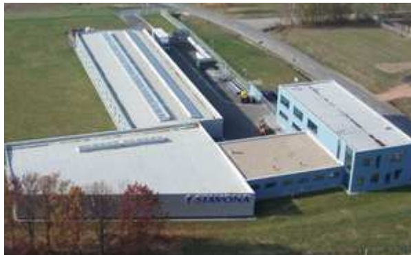
obrázek 6: Výrobní hala společnosti Stavona
