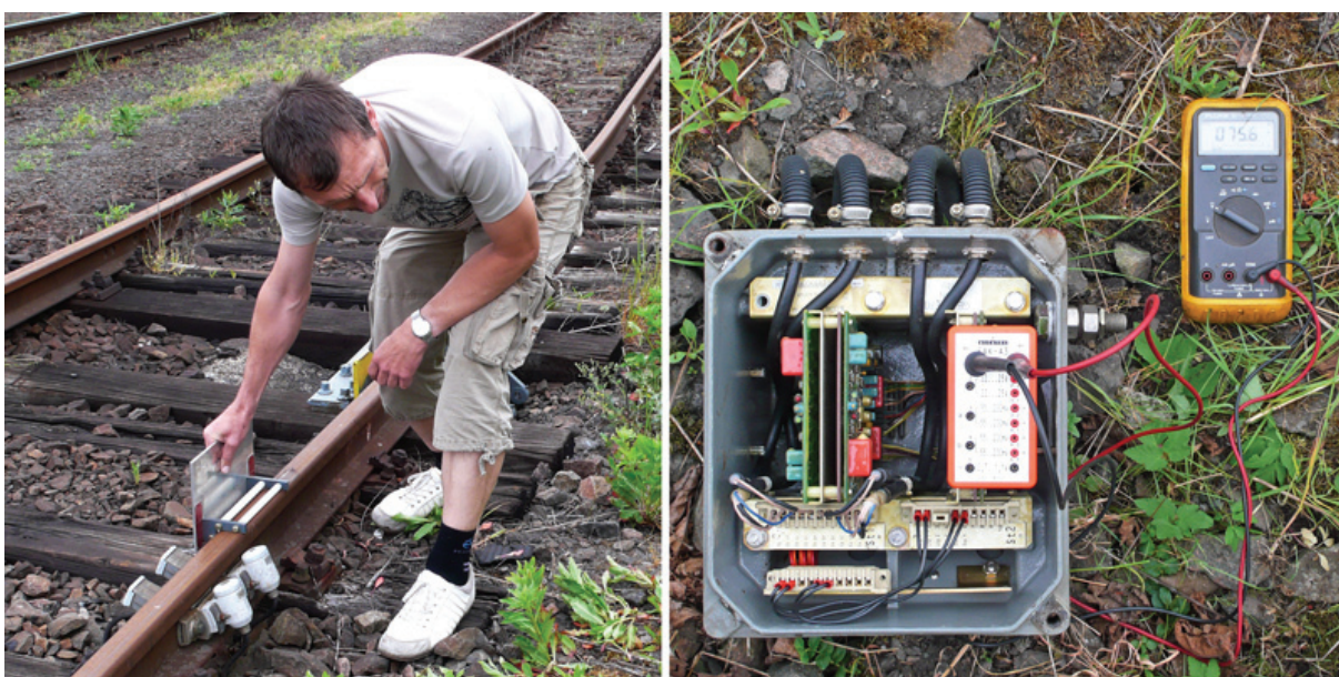
Obrázek 8: Použití speciální měrky na simulaci průjezdu kola a měření na zkušebním adaptéru v železniční stanici Káranice
