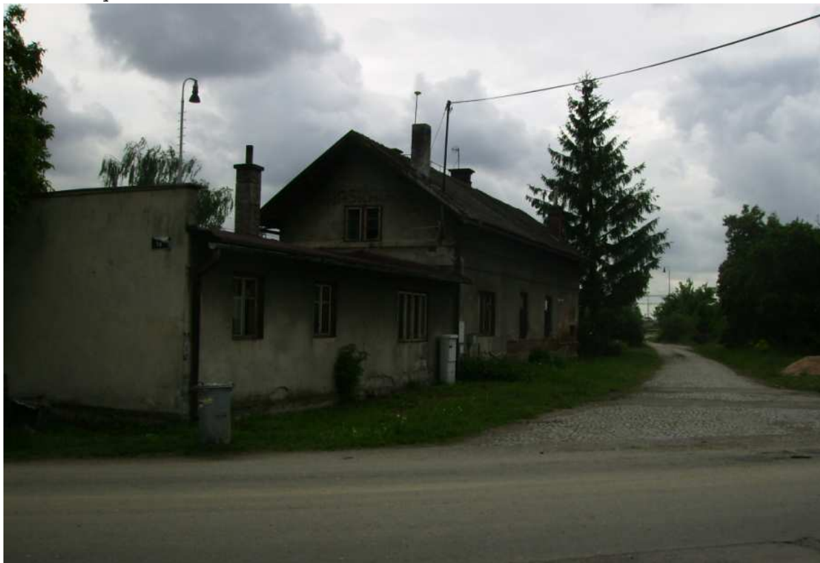
obr. E3 bývalé nádraží Praskačka
