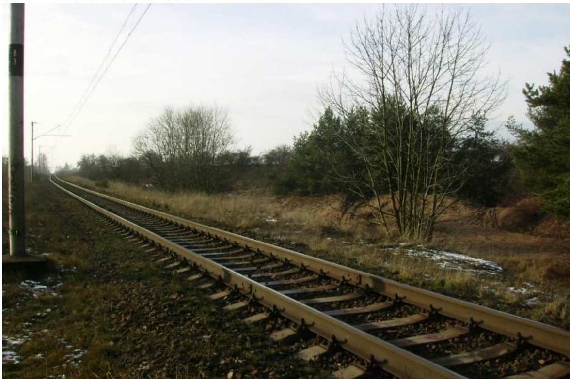
obr. H1 železniční trať
