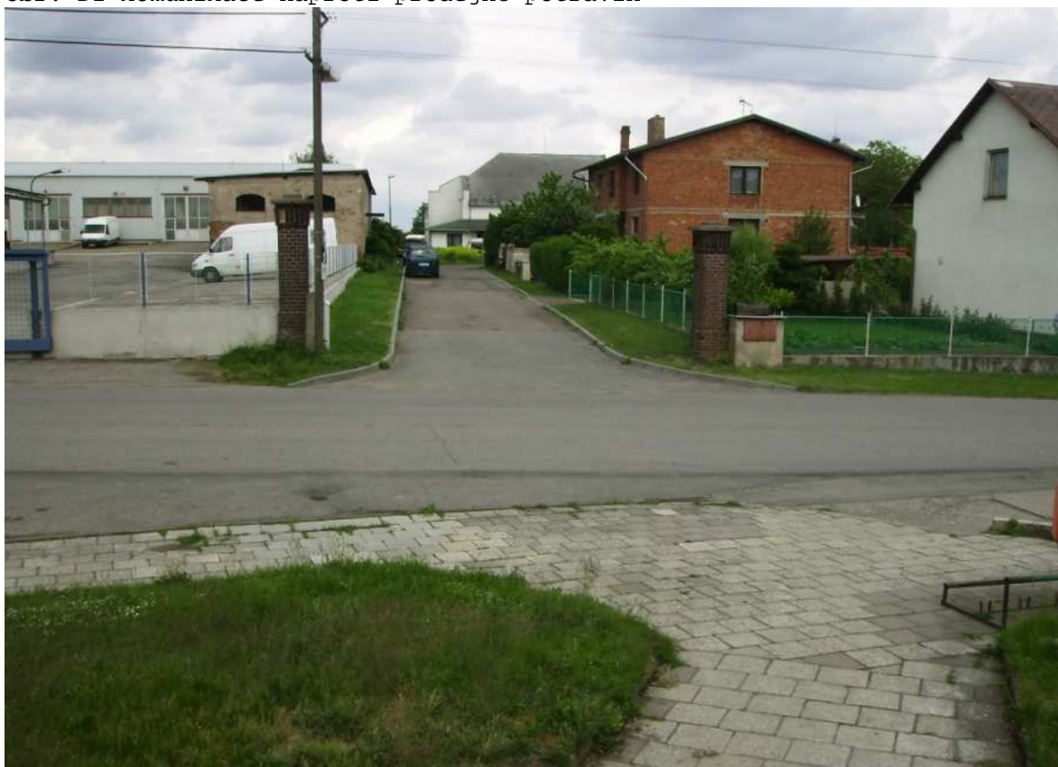
obr. D2 komunikace naproti prodejně potravin
