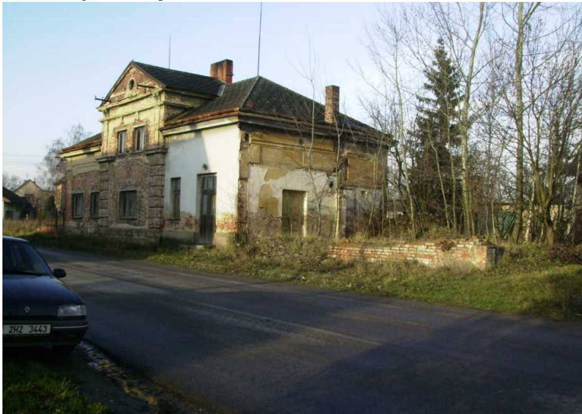
obr. E2 objekt určený k demolici
