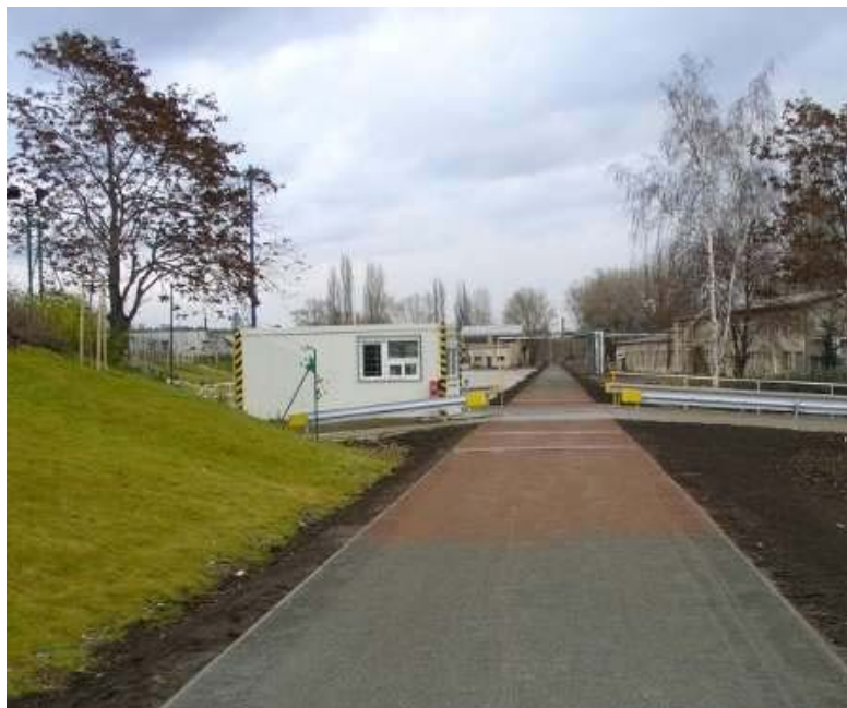
Obr. 27. Stezka s mlatovou úpravou [30]
