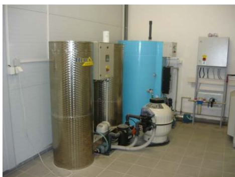
Obr. č. 8: Čistička odpadních vod
