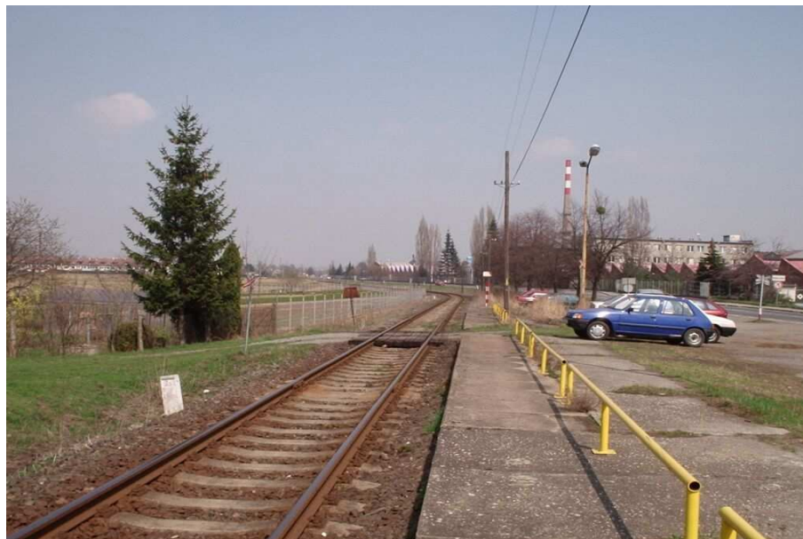
Obrázek 16 – Bývalá zastávka Hradec n. Moravicí, Brano (vpravo areál Brano a.s.) Zdroj: Fotoarchiv autora
