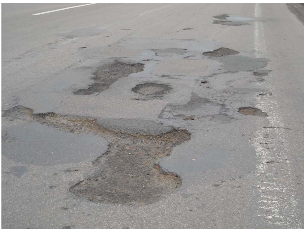
Obrázek č. 10 – Povrch vozovky č. 11
