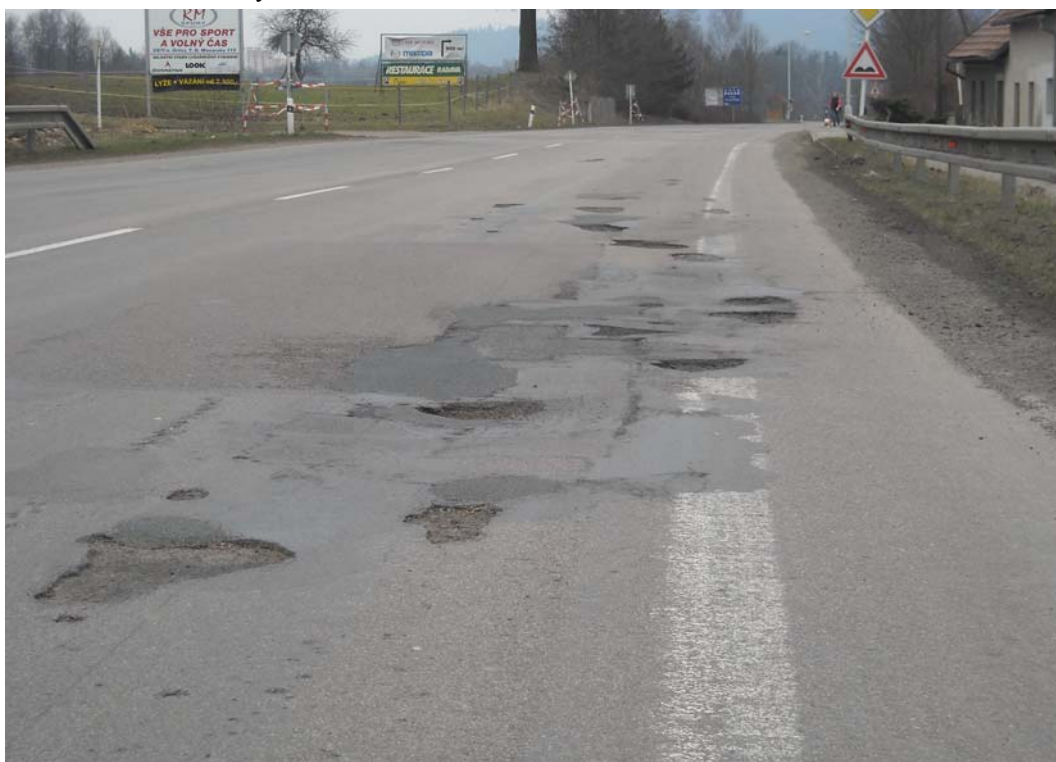
Obrázek č. 9 – Povrch vozovky č.11
