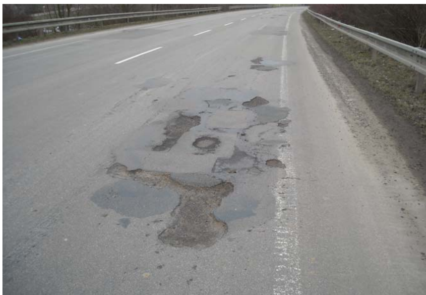
Obrázek č. 8 – Povrch vozovky č.11
