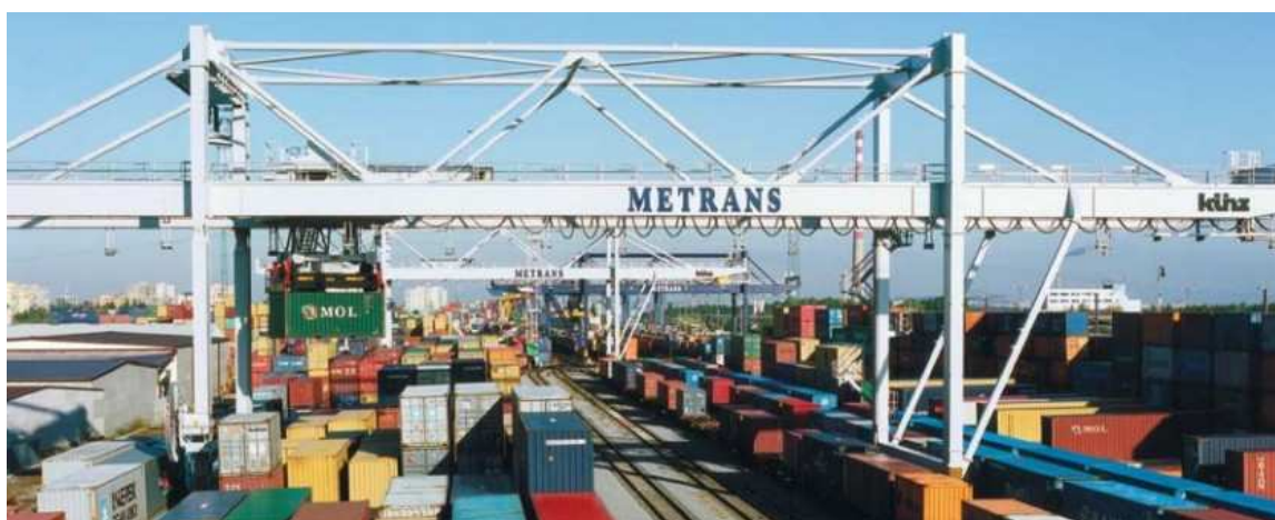
Obrázek 16 – Portálové jeřáby situované v terminálu Praha-Uhřetěves Zdroj: [7]
