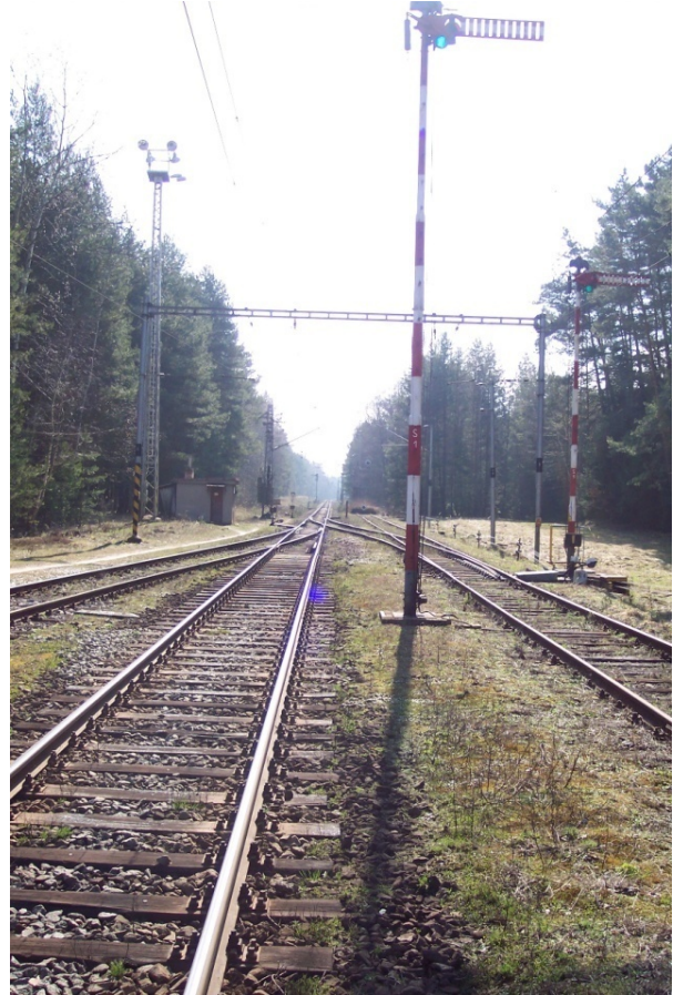
Obrázek 10 - Pohled z žel. přejezdu na choceňské zhlaví
