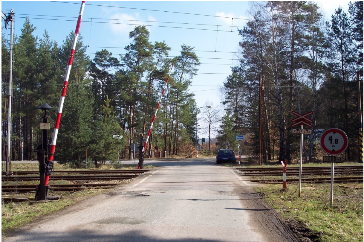
Obrázek 5 - Železniční přejezd - pohled směr Čermná nad Orlicí
