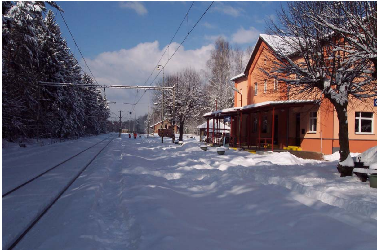
Obrázek 21 - Stanice v zimě, pohled z 2. nástupiště na výpravní budovu
