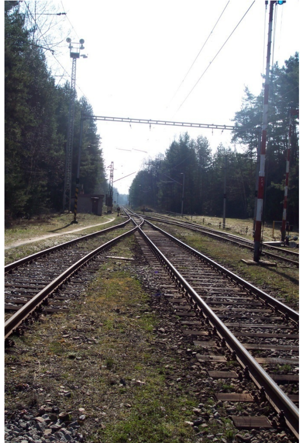
Obrázek 4 - Pohled z žel. přejezdu na choceňské zhlaví
