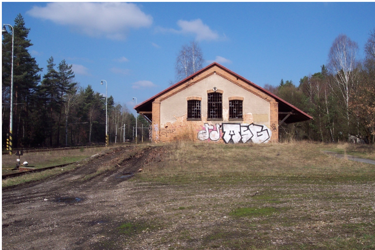
Obrázek 17 - Volná skládka a skladiště s rampou
