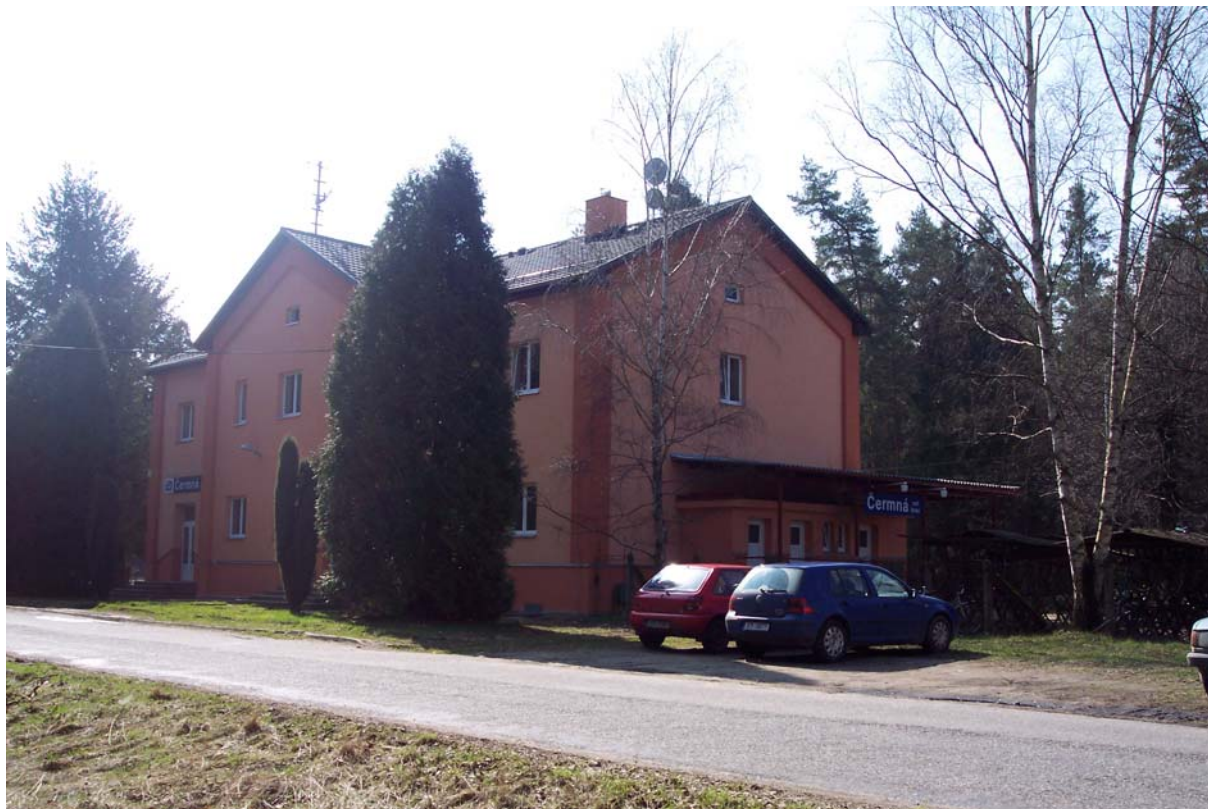
Obrázek 26 - Pohled na výpravní budovu s přednádražím
