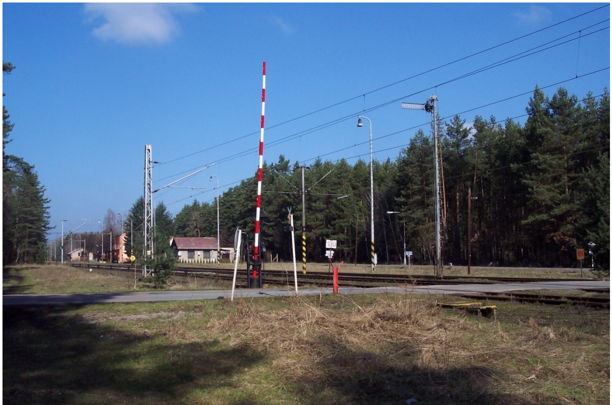
Obrázek 11 - Pohled na železniční přejezd, v pozadí výpravní budova
