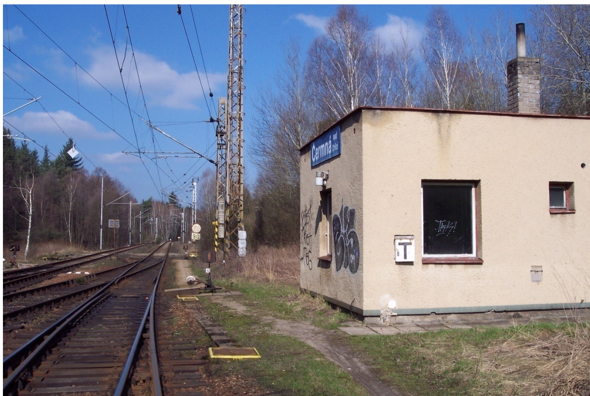
Obrázek 16 - Pohled z první koleje na širou trať směr Borohrádek, vlevo vojenská vlečka
