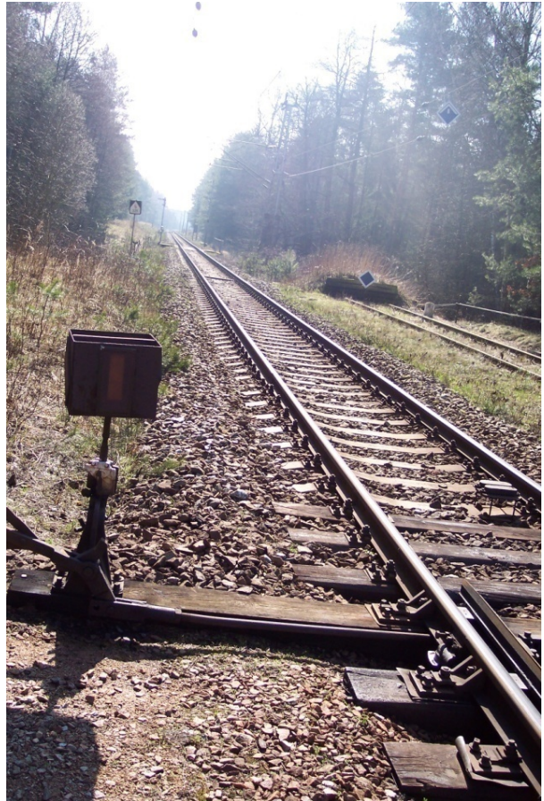
Obrázek 7 - Pohled na kolej 1. a odvrtnou kolej 3a
