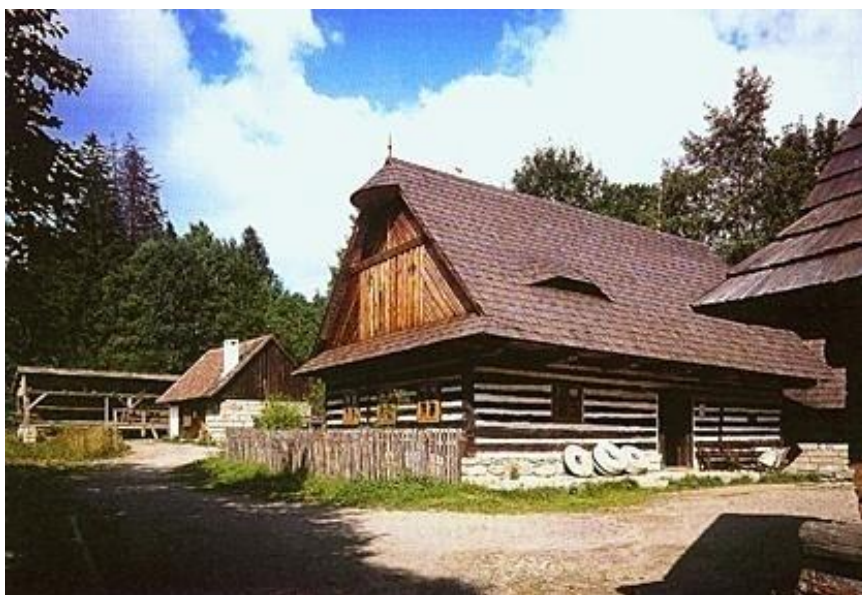
Obr. 13: Skanzen Vysočina; zdroj: http://www.pruvodce.com/_pictures/p/00142_09.jpg
