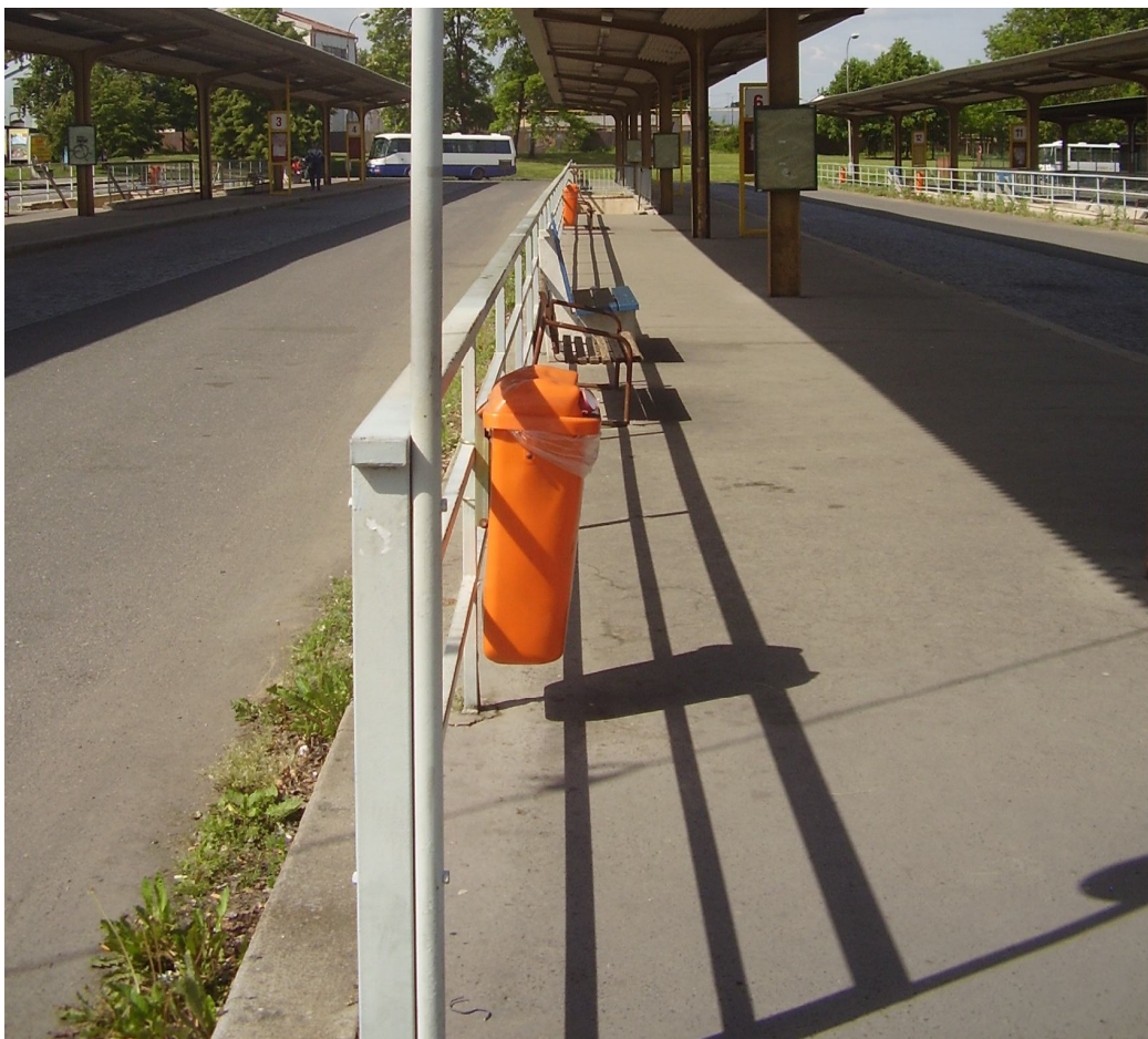
Obrázek 2: Zábradlí na nástupišti
