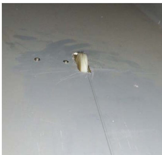
Obr.7 Kladka v tunelu
