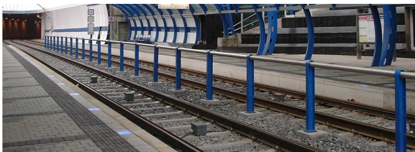
Obrázek 14: Světelné body na hranici nástupního ostrůvku ve stanici
