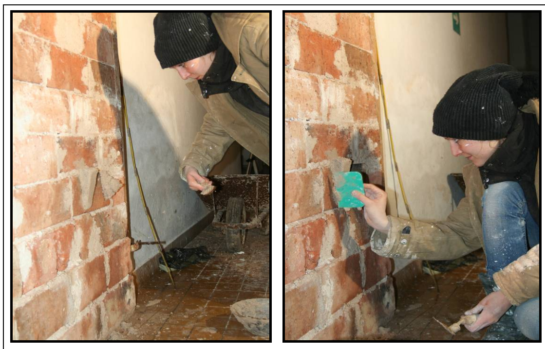
Obr. 20 Proces nanášení na zeď
