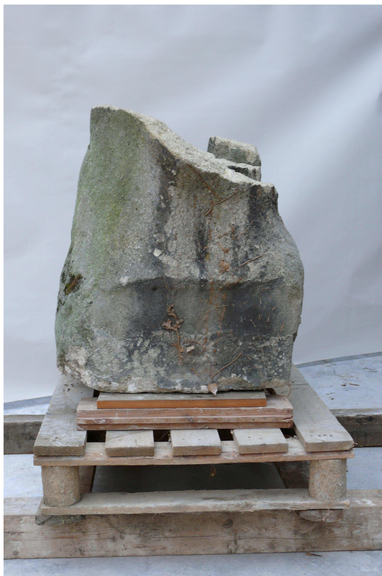
Obr. 6 – stav před restaurováním
