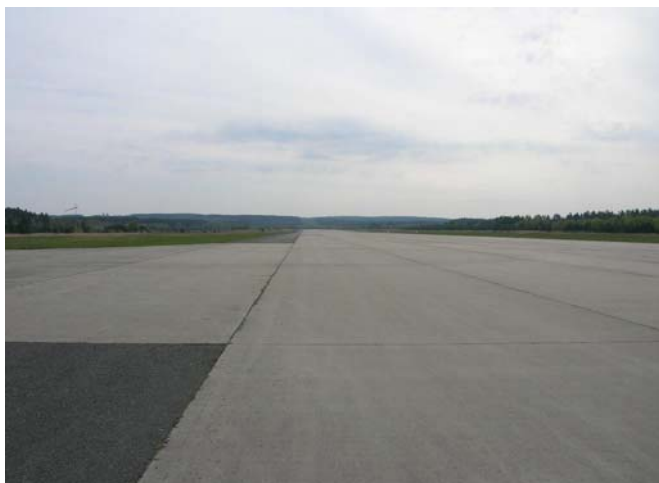
Obr.9: Pohled na zkušební dráhu letiště v Mimoni
